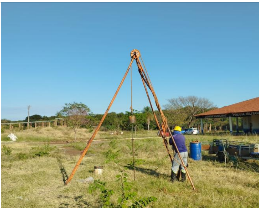
Foto 3.1 – Execução do SPT-01.
