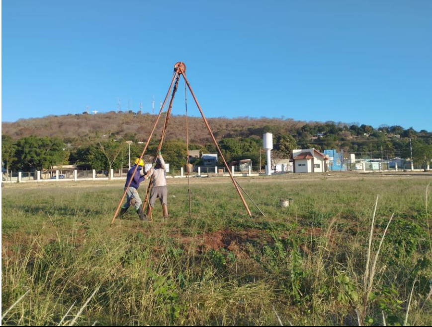
Foto 3.11 – Execução do SPT-06.
