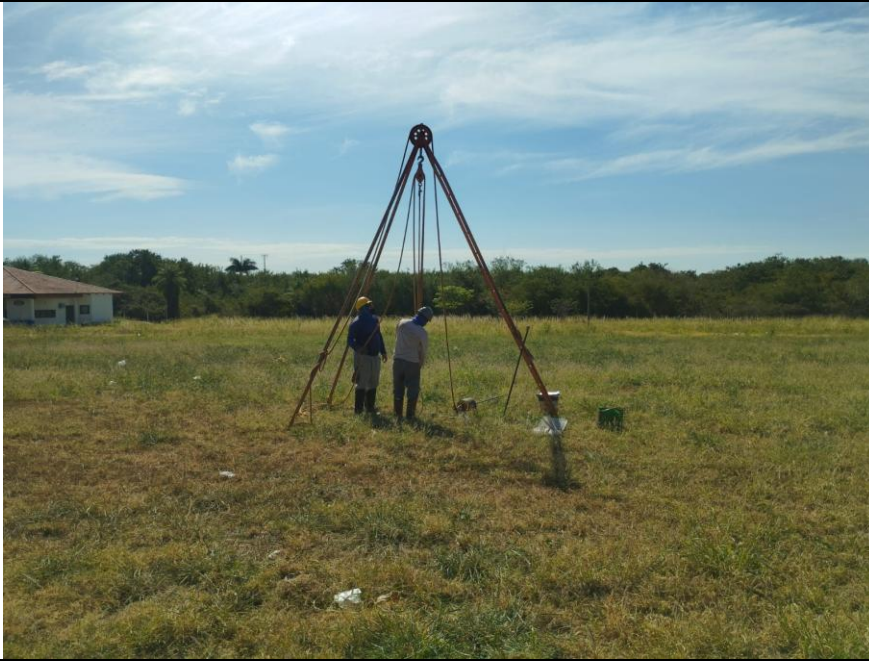
Foto 3.19 – Execução do SPT-10.
