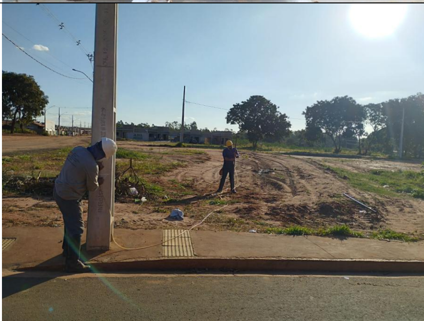
Foto 3.41– Determinação do RN.(poste de energia);
