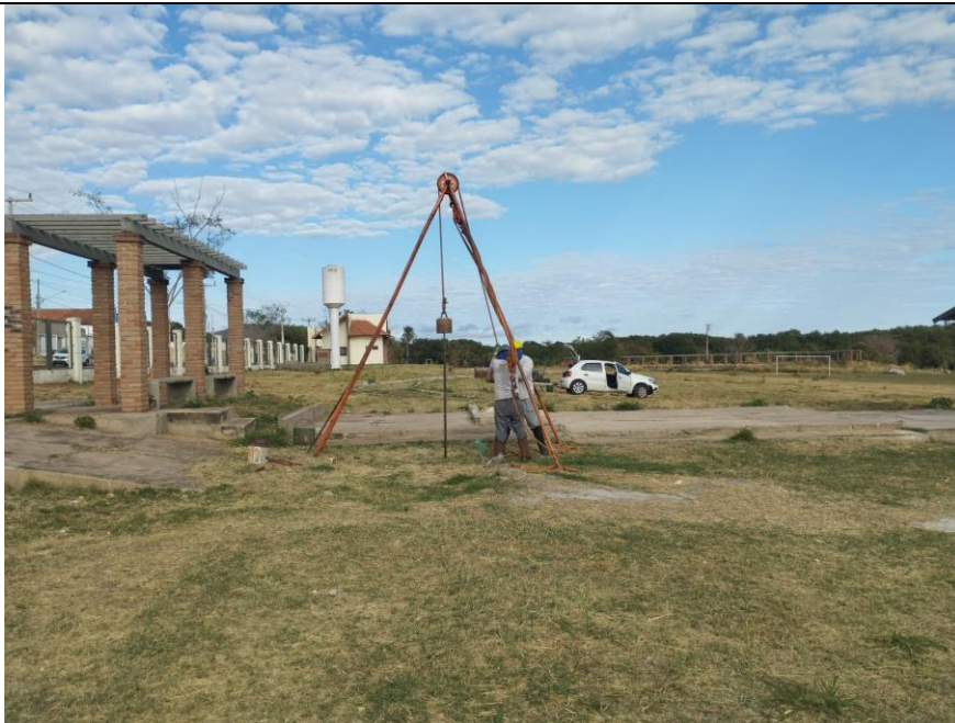
Foto 3.39 – Execução do SPT-20.
