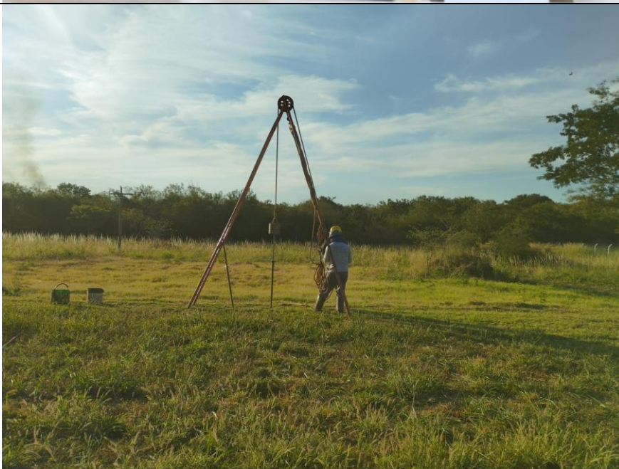
Foto 3.13 – Execução do SPT-07.
