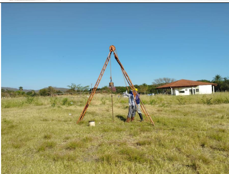
Foto 3.5 – Execução do SPT-03.
