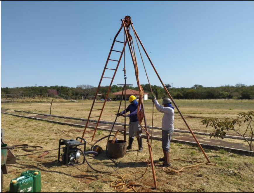
Foto 3.35 – Execução do SPT-18.
