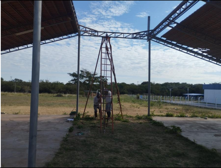
Foto 3.31 – Execução do SPT-16.
