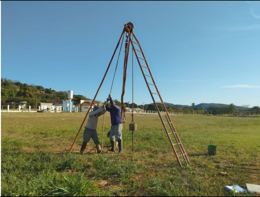
Foto 3.15 – Execução do SPT-08.
