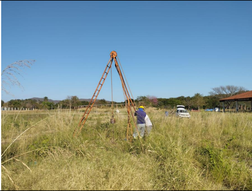
Foto 3.3 – Execução do SPT-02.
