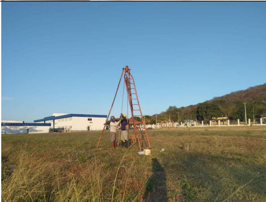
Foto 3.9 – Execução do SPT-05.
