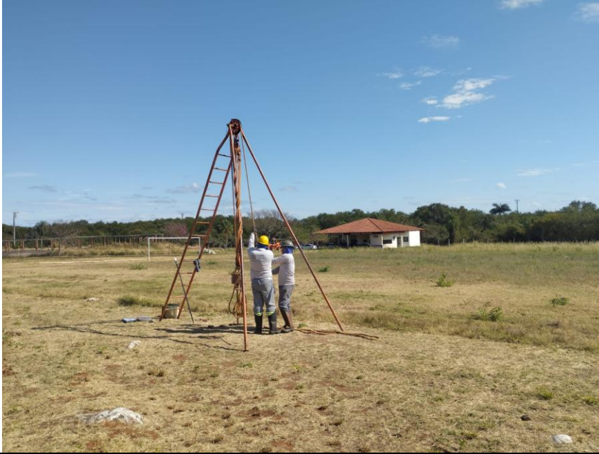
Foto 3.27 – Execução do SPT-14.
