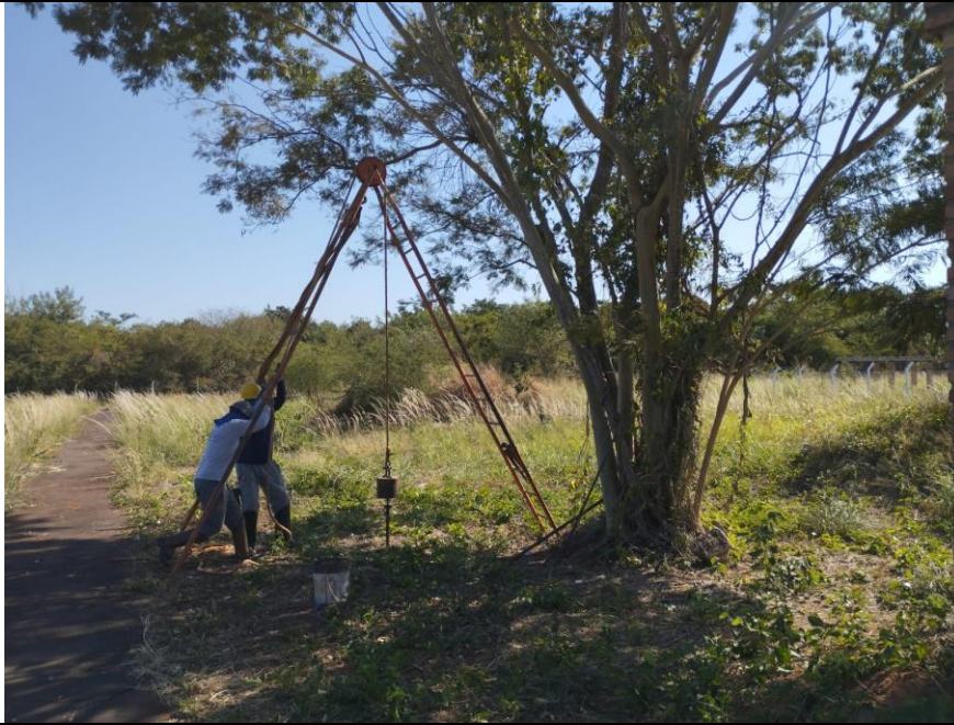
Foto 3.7 – Execução do SPT-04.
