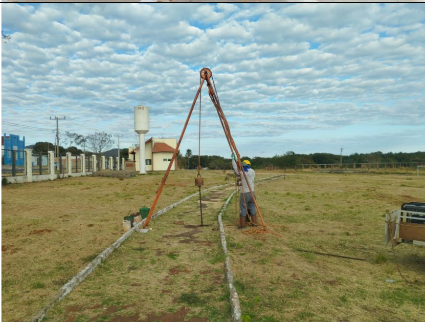
Foto 3.37 – Execução do SPT-19.
