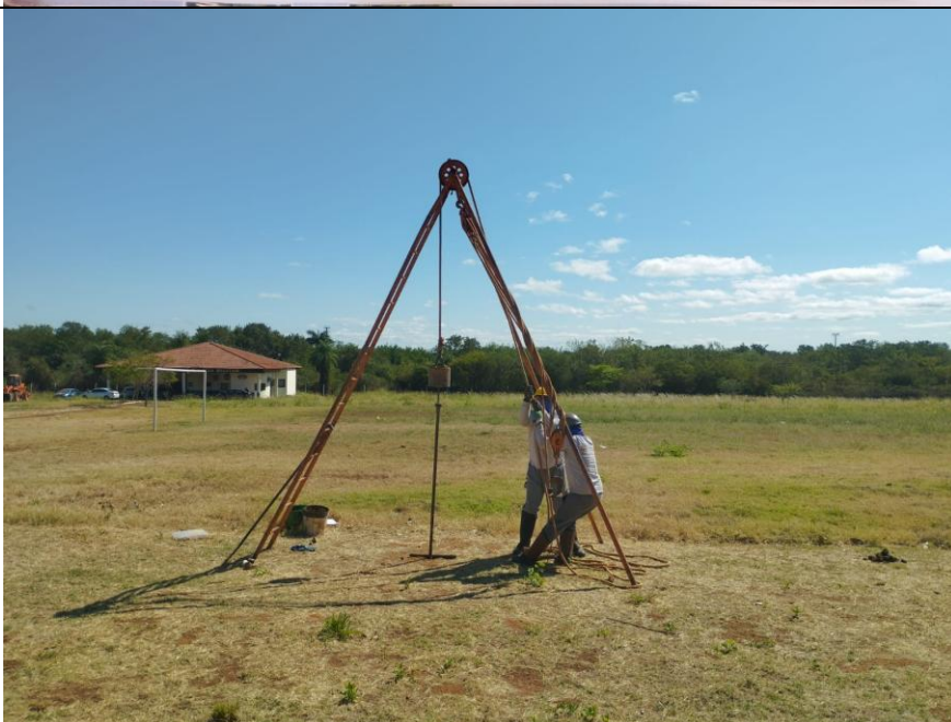
Foto 3.25 – Execução do SPT-13.
