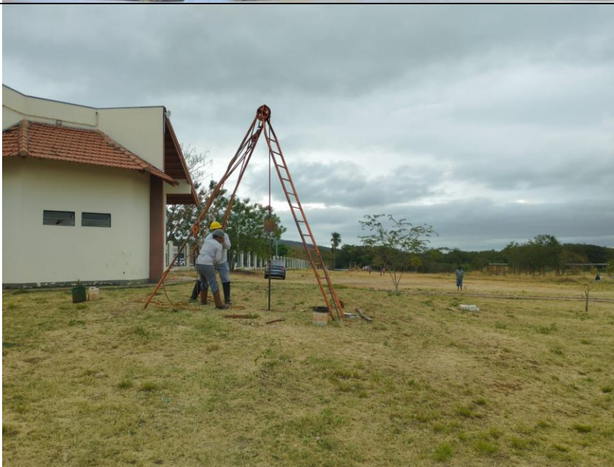
Foto 3.33 – Execução do SPT-17.
