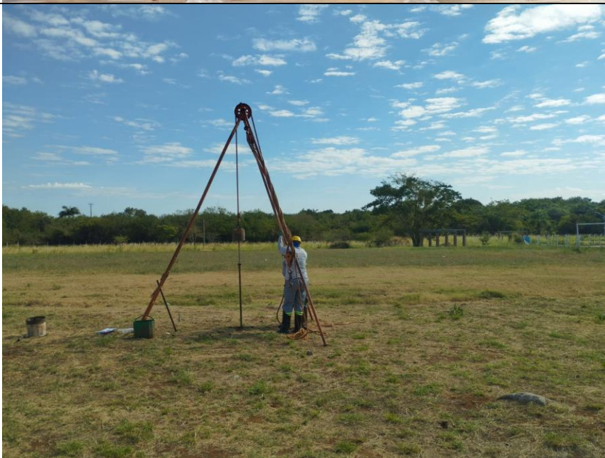
Foto 3.29 – Execução do SPT-15.
