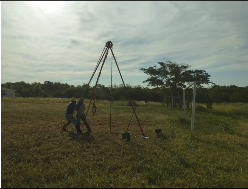
Foto 3.23 – Execução do SPT-12.
