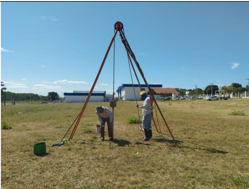
Foto 3.17 – Execução do SPT-09.
