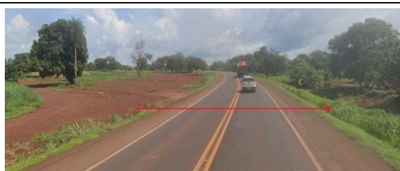
Imagem 01 – Local da travessia da rede coletora na BR-163/MS seta indica sentido do fluxo da linha de recalque (UTM: 766878.31 E, 7603808.59 S – data: 12/2024 fontes: Google Earth e projeto georeferenciado)
