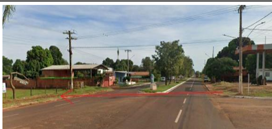
Imagem 01 — Local da travessia da rede coletora na MS-162 seta indica sentido do fluxo (PV-24 a montante UTM: 695814.00 E, 7705015.00 S ao PV-25 a jusante UTM: 695791.00 E, 7705001.00 S — data: 06/2025 fontes: Google Earth e projeto georeferenciado)
