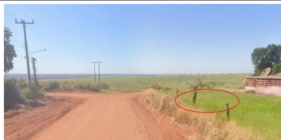
Imagem 04 — Região de implantação da Elevatória (PV-152 de chegada UTM: 697268.65 E, 7705310.72 S — data: 05/2023 fontes: Google Earth e projeto georeferenciado)
