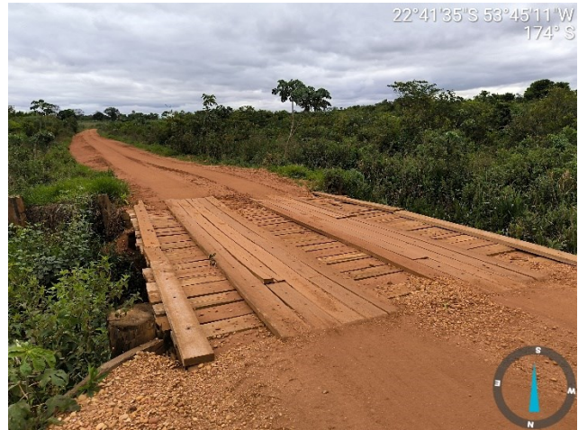
Imagem 22 – Ponte de Madeira sobre a Vazante do Córrego Juqueri na MS-491
