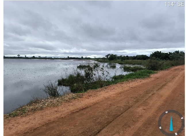
Imagem 12 – MS-491, Barragem de Terra da Lagoa da Fazenda Bandeirantes
