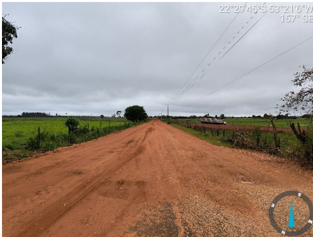
Imagem 03 – MS-473, Início do trecho no município de Taquarussu
