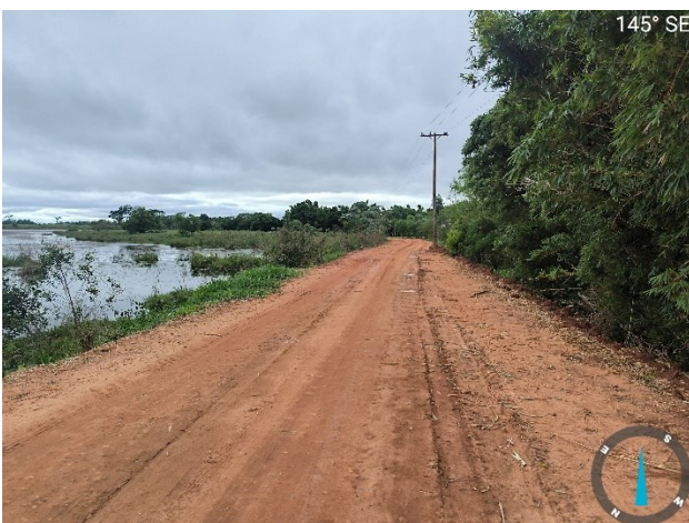
Imagem 13 – MS-491, Barragem de Terra da Lagoa da Fazenda Bandeirantes
