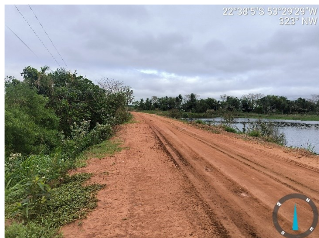
Imagem 14 – MS-491, Barragem de Terra da Lagoa da Fazenda Bandeirantes
