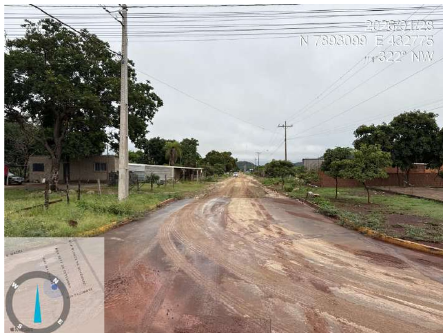
Figura 12 – Foto 10 (Rua Major Gama)
