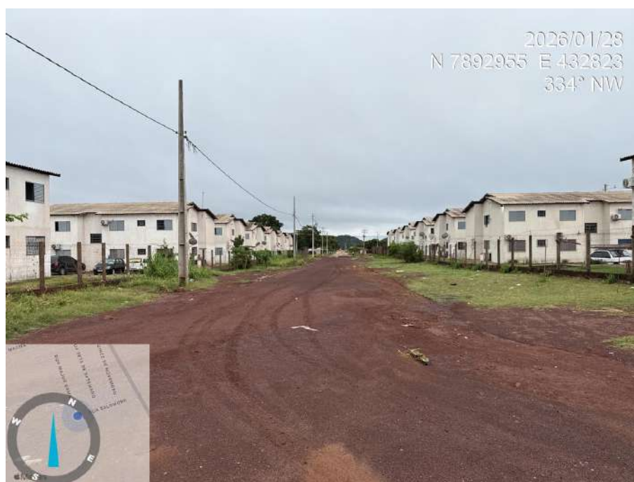
Figura 6 – Foto 04 (Rua Major Gama)
