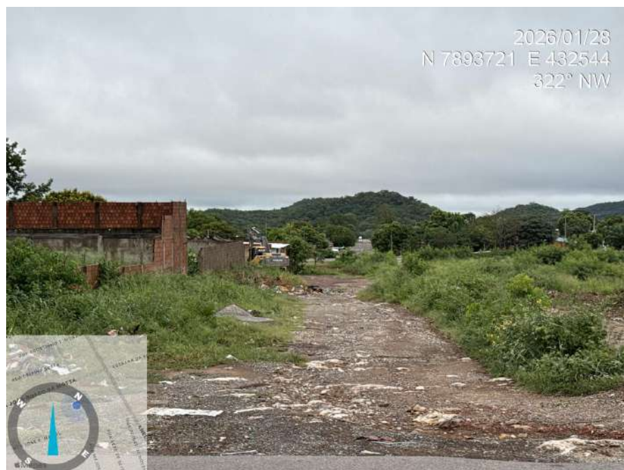
Figura 22 – Foto 20 (Rua Major Gama)
