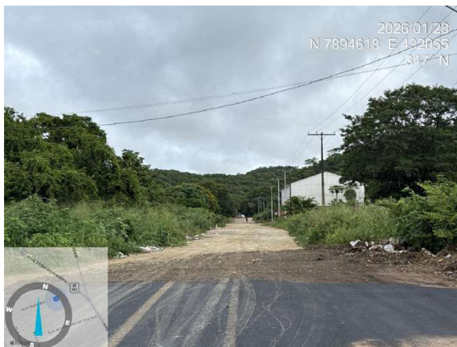
Figura 39 – Foto 37 (Rua Firmo de Matos)
