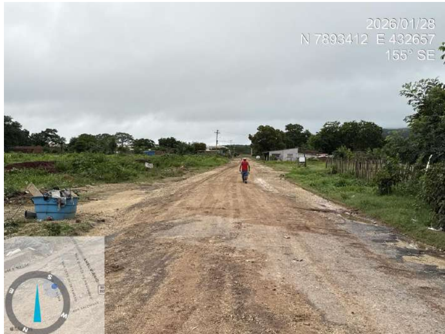
Figura 19 – Foto 17 (Rua Major Gama)
