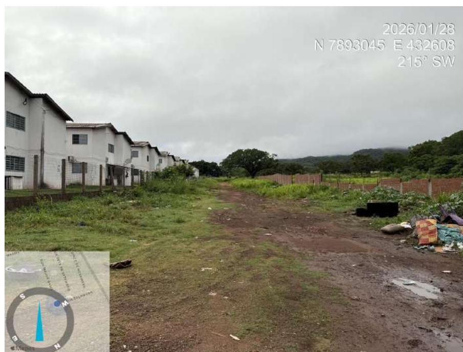
Figura 8 – Foto 06 (Rua Firmo de Mattos)
