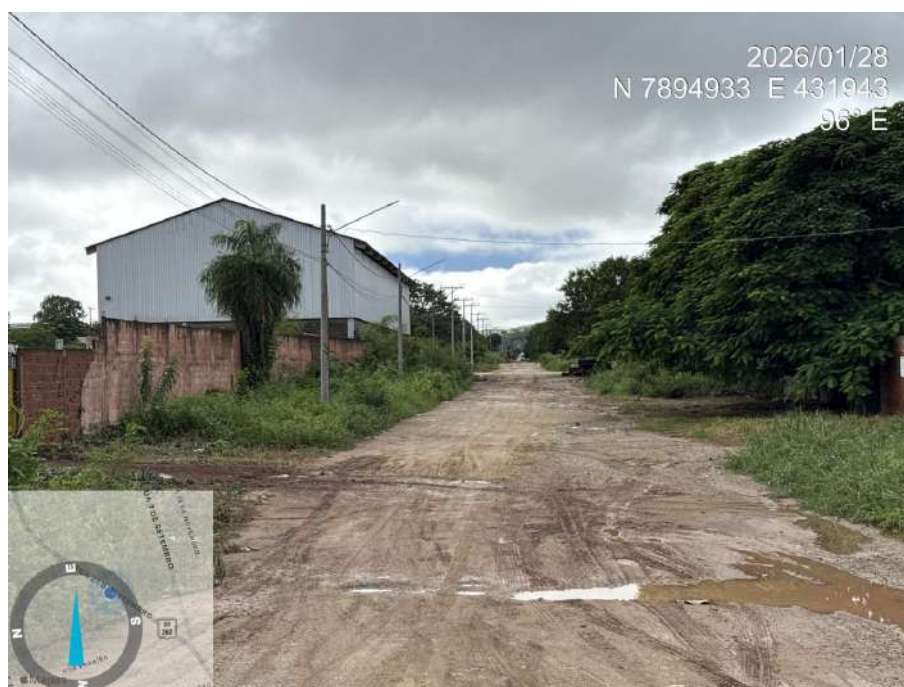
Figura 40 – Foto 38 (Rua Firmo de Matos)
