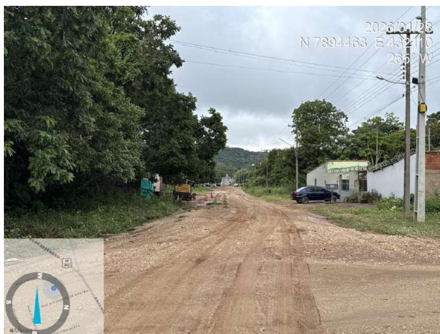
Figura 36 – Foto 34 (Rua Firmo de Matos)
