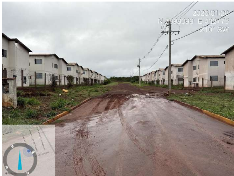
Figura 11 – Foto 09 (Rua Major Gama)
