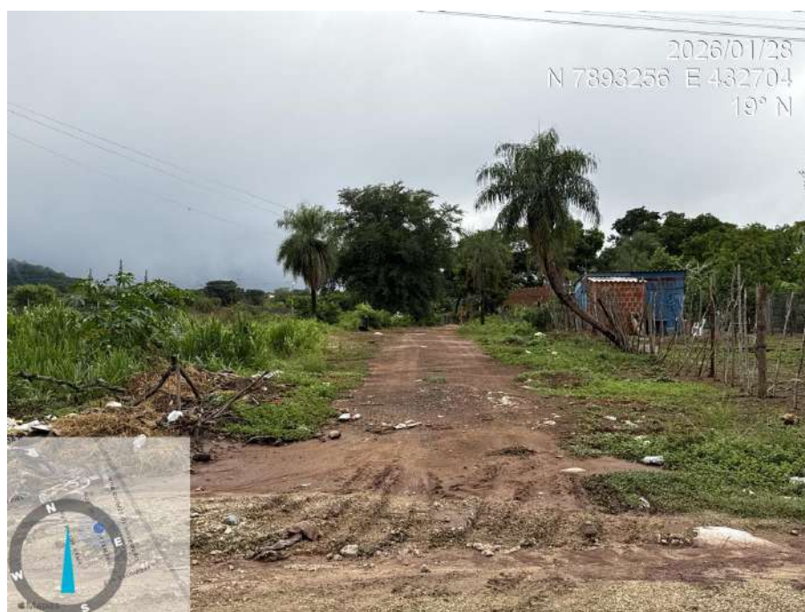
Figura 18 – Foto 16 (Rua I. Macellaro)
