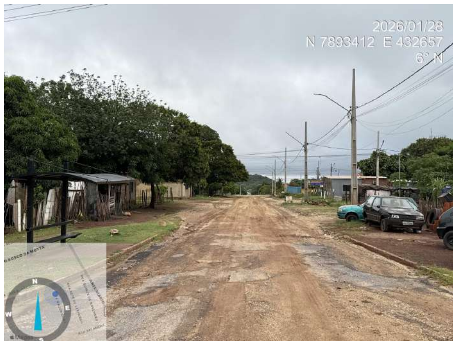
Figura 20 – Foto 18 (Rua Major Gama)
