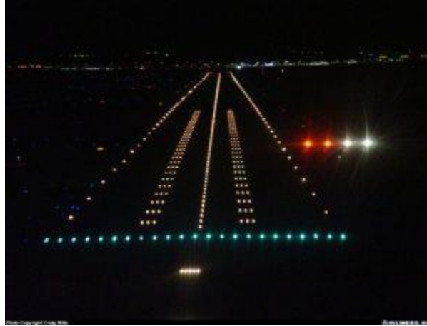
Figura 1. Demonstração do PAPI (lado direito da pista) em outro aeroporto com luzes vermelha e branca (fonte: site asas brasil)
