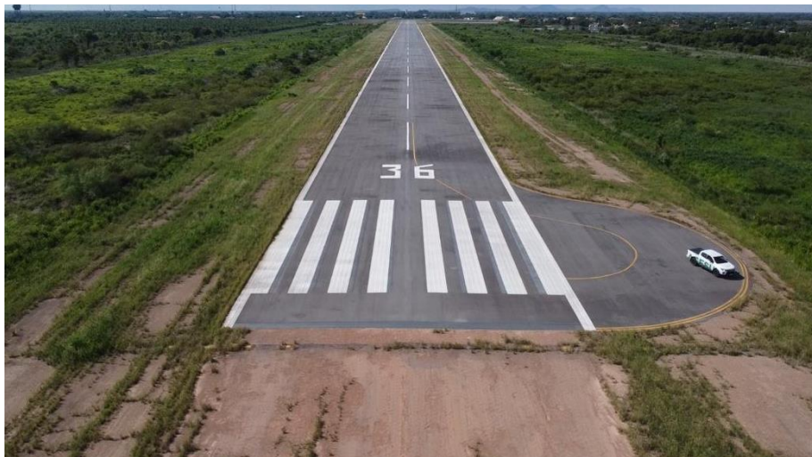
Figura 8. Vista da Cabeceira 36 no Aeroporto de Porto Murtinho-MS
