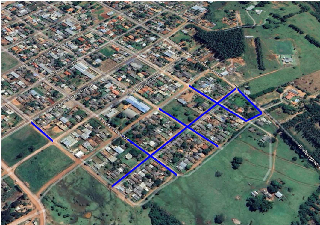
Figura 1 – Implantação da pavimentação no Bairro Jardim Antunes – Etapa 2, traçado em azul Fonte: Autor, 2026
