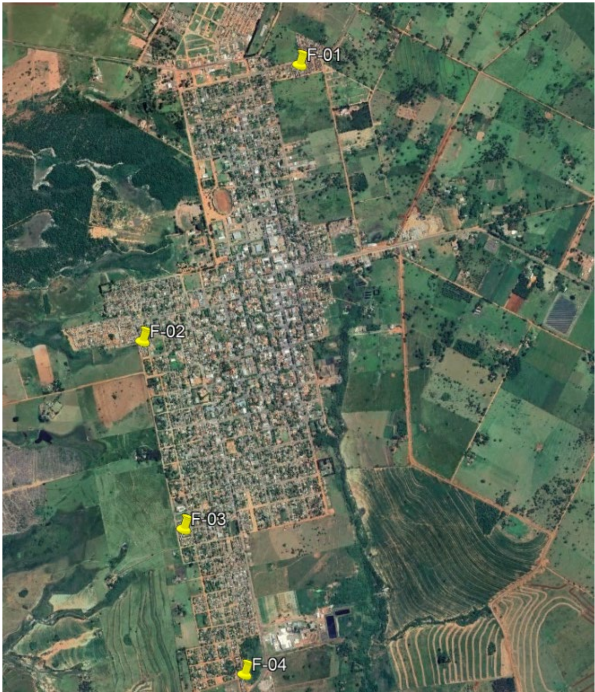
IMAGEM DOS FUROS DE SONDAGEM DA REGIÃO DE IGUATEMI - MS
