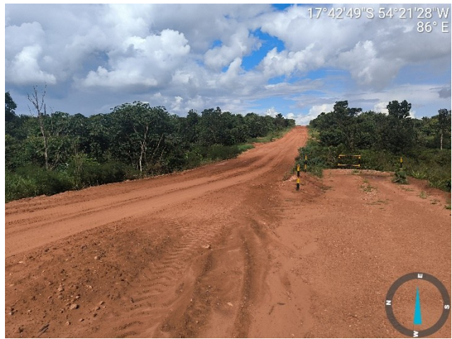
Imagem 09 – MS-213, Galeria em córrego
