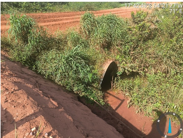
Imagem 10 – MS-213, Galeria em córrego
