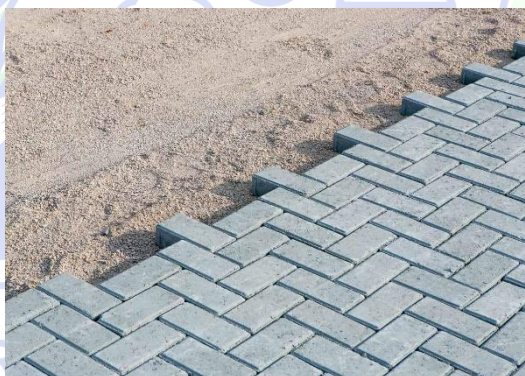
Foto 01: Assentamento de intertravado retangular na cor natural
