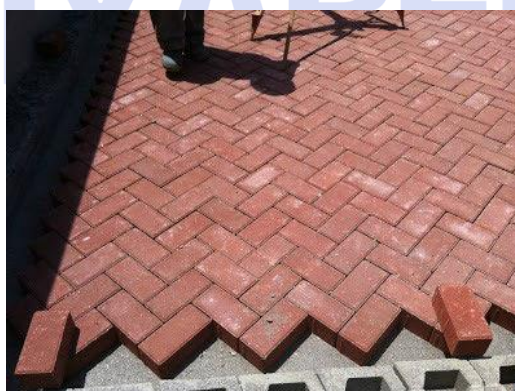
Foto 02: Assentamento de intertravado retangular na cor vermelha
