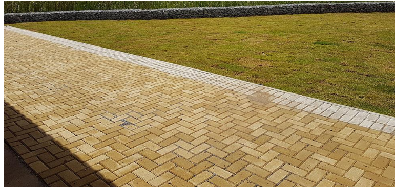
Foto 03: Assentamento de intertravado retangular na cor amarela
