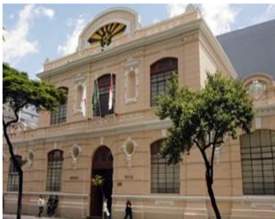
Figura 1 – Edifício Imprensa Oficial de Minas Gerais
