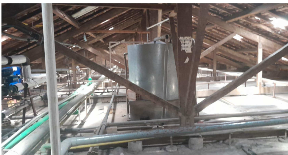
Barriletes de Água Quente e Água Fria sob telhado
