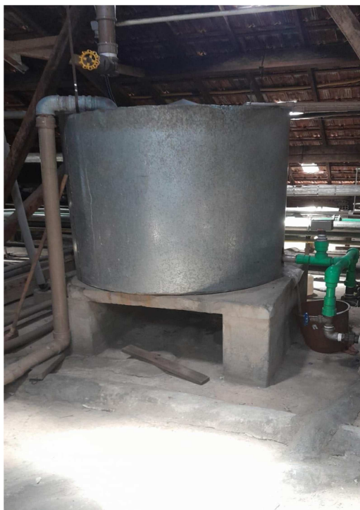
Barriletes e Boiler de Água Quente sob telhado
