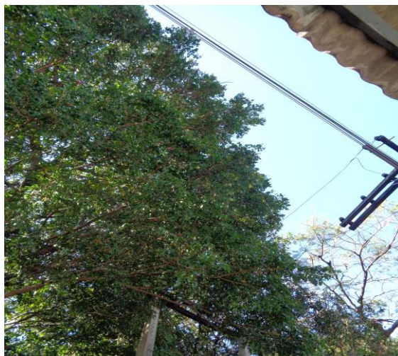
3 – Árvore, Cajamanga, com galhos sobre transformador.
