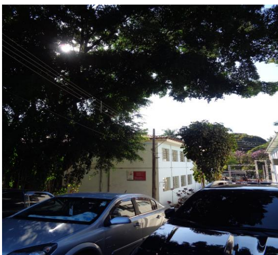
2 – Árvore, Ficus benjamina, com galhos sobre rede elétrica.
