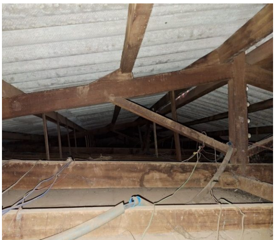
Fotos do engradamento e forro de PVC
