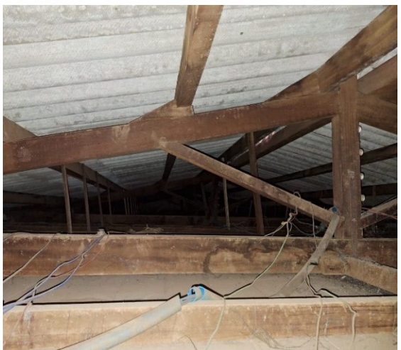
Fotos do engradamento e forro de PVC
