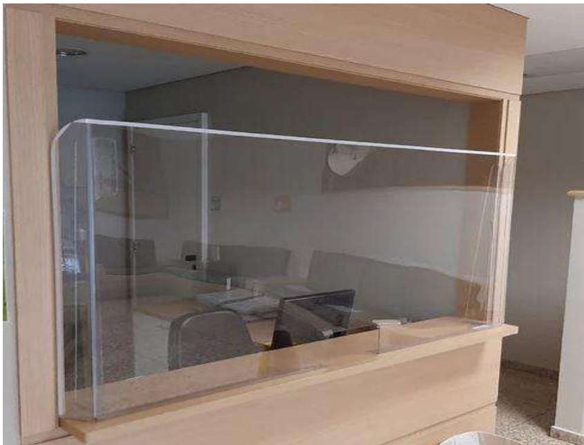
Imagem 12: Barreira de proteção em Acrílico
