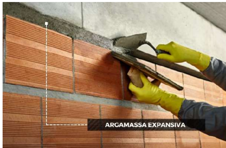
Imagem 02: Encunhamento de alvenaria com argamassa expansiva
