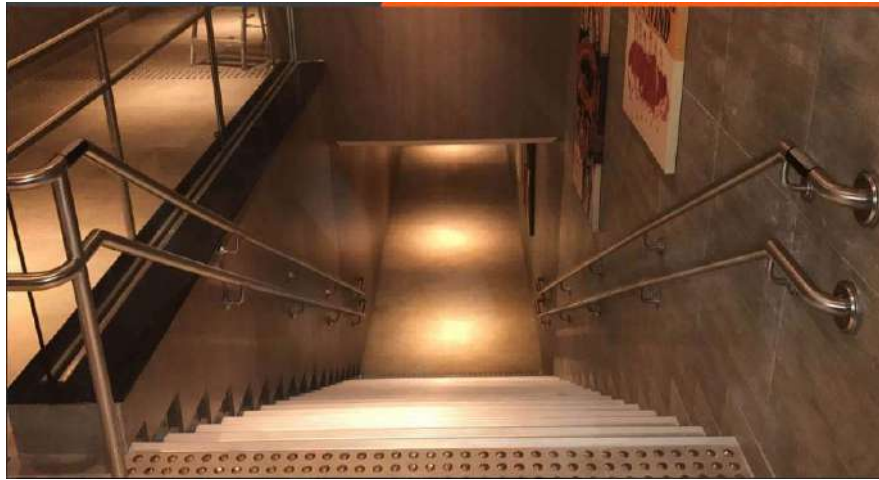
Imagem 10: Corrimão de escada
