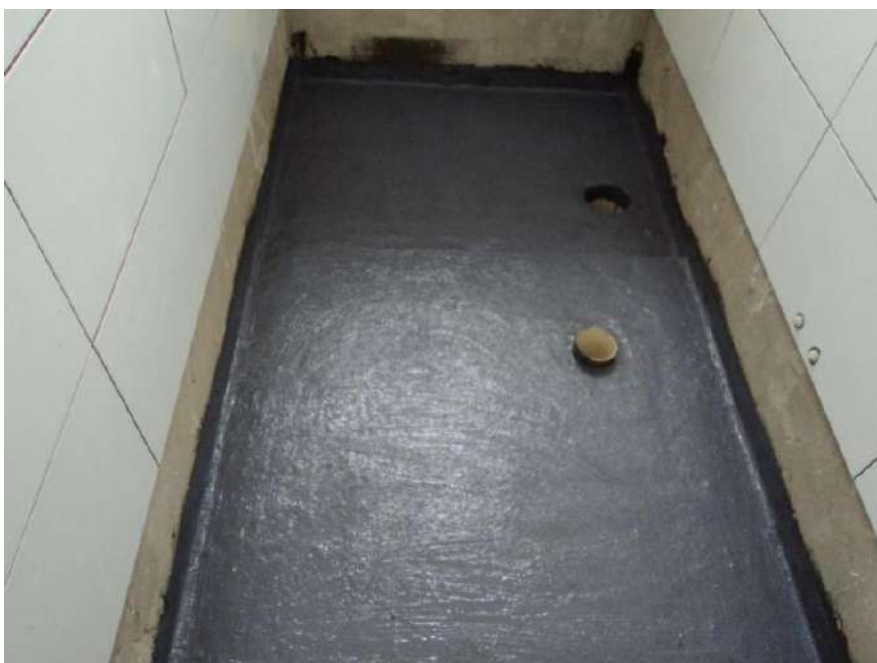
Imagem 13: Impermeabilização com argamassa polimérica
