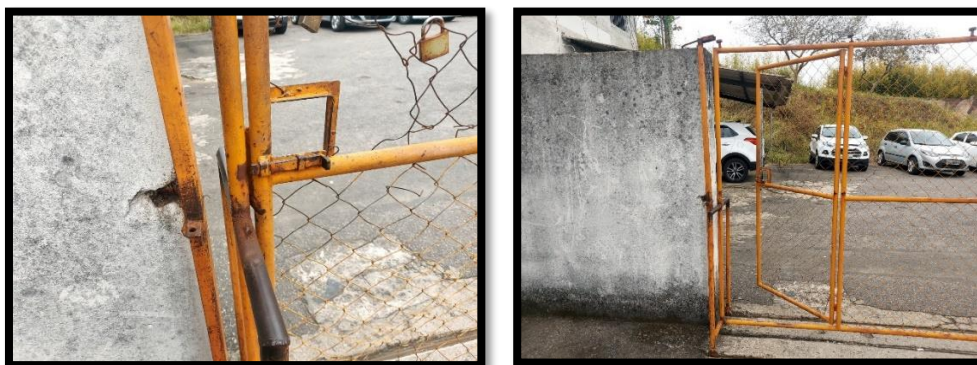
Fig's. 20 e 21 – Portão de Pedestres
