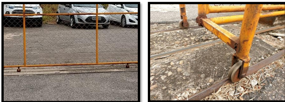
Fig's. 23 e 24 – Sistema de Rolamento Sobre Trilhos (Atuais)
