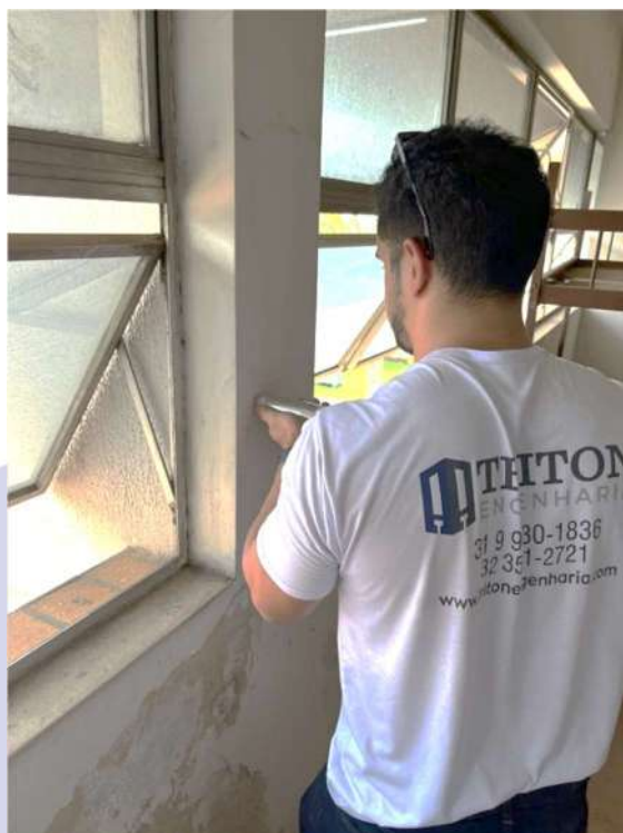
Figura 4 - Ensaio realizado utilizando o esclerômetro no 18° BPM (Fonte: O Autor)
