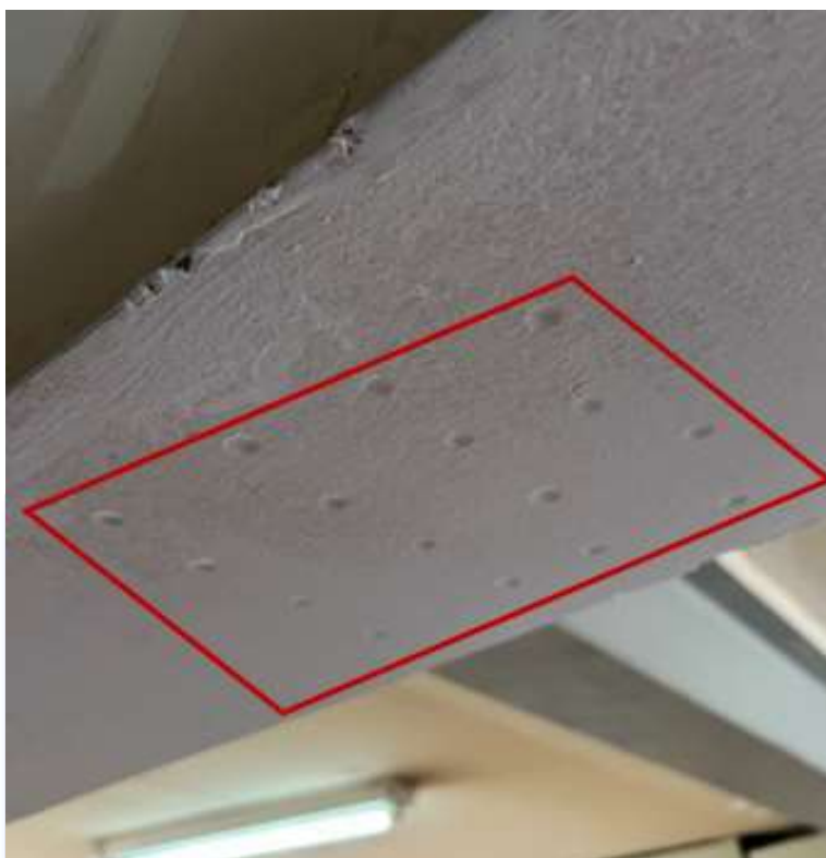
Figura 5 - Área de ensaio realizado em viga no 18º BPM (Fonte: O Autor)
