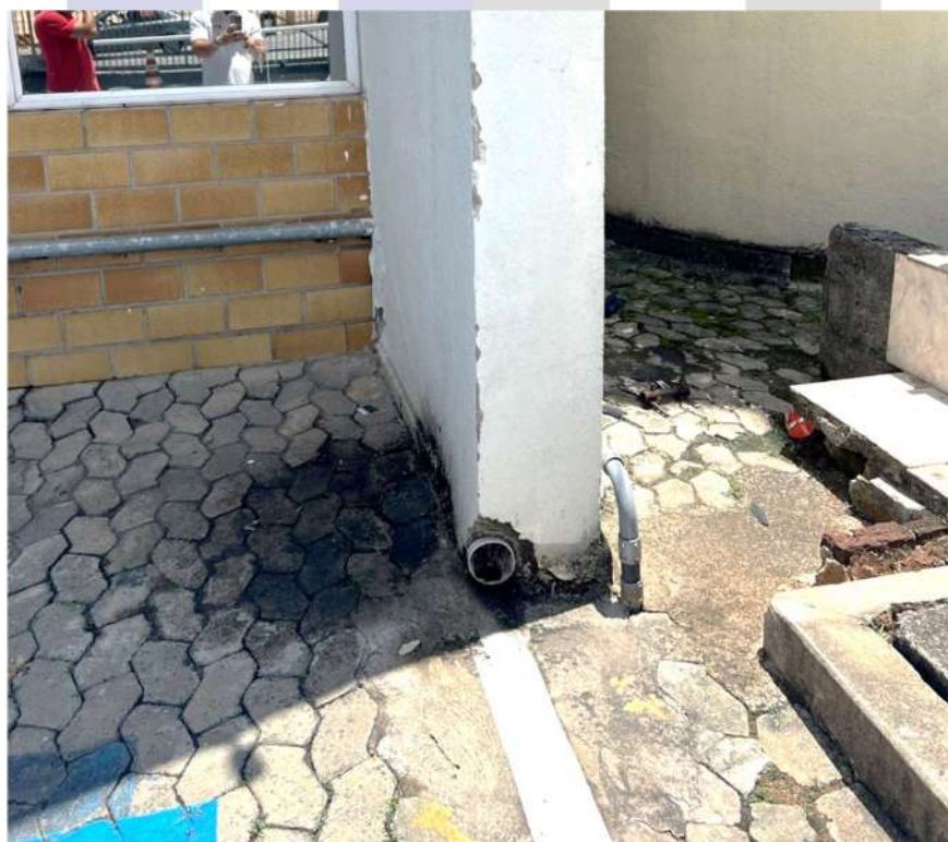
Figura 25 – Excesso de umidade causado por aparelho de ar-condicionado que não possui dreno (Fonte: O Autor)
