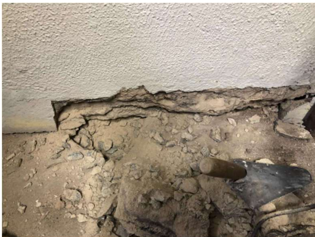
Figura 16 – Escavação do encontro entre muro de contenção e piso no depósito de materiais (Fonte: Thiago Barradas – CPO)
