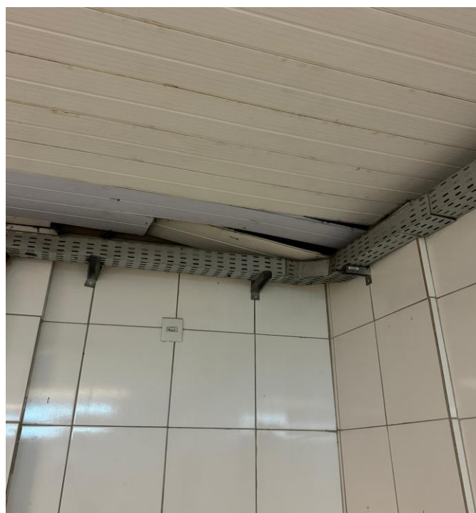
Fotos 04 e 05 – Danos internos causados por infiltrações no telhado do Refeitório do BOPE/PMMG
