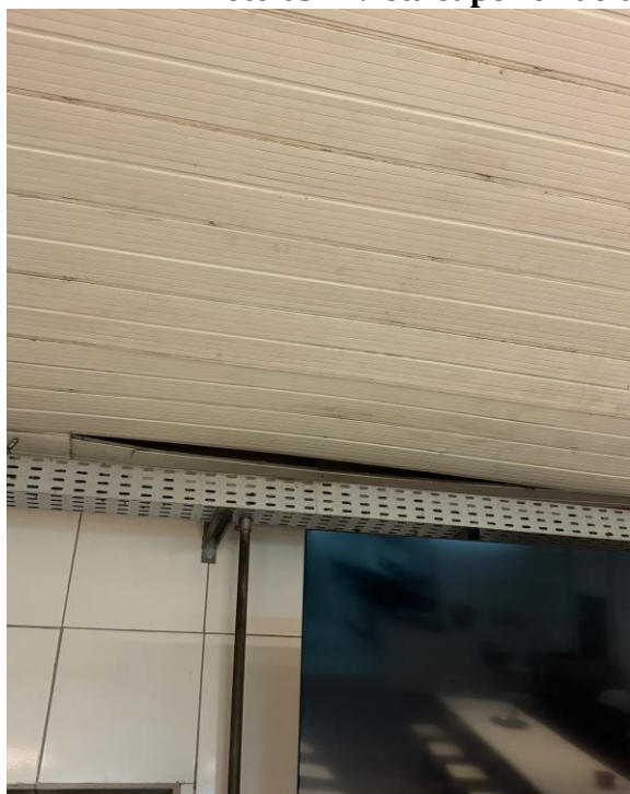
Fotos 04 e 05 – Danos internos causados por infiltrações no telhado do Refeitório do BOPE/PMMG
