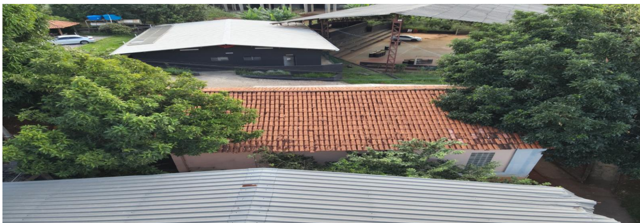
Foto 02 – Vista superior do telhado do Refeitório do BOPE/PMMG
