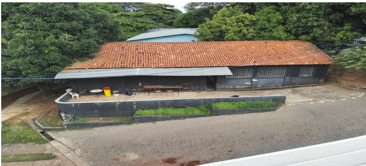
Foto 01 – Vista externa do Refeitório do BOPE/PMMG
