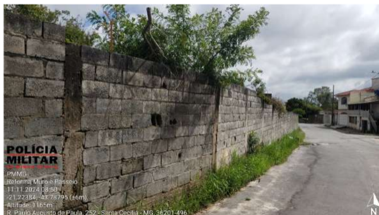
Figura 5 – Muro frontal: Parte desmoronada
