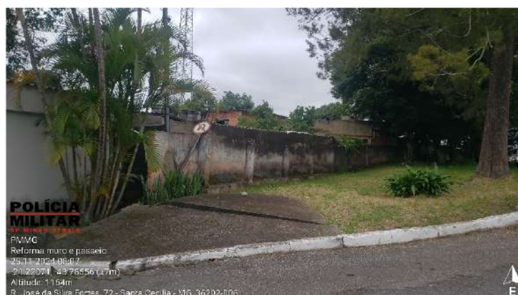
Figura 3 – Muro dos Lateral até a divisa com o condomínio
