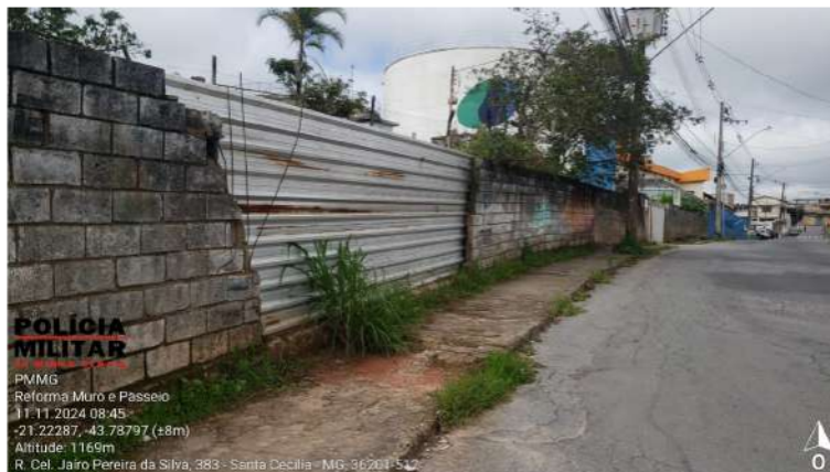
Figura 5 – Muro frontal: Parte desmoronada
