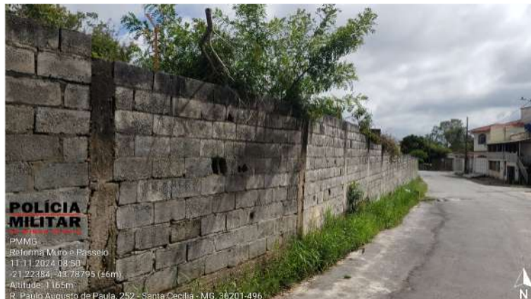
Figura 5 – Muro frontal: Parte desmoronada
