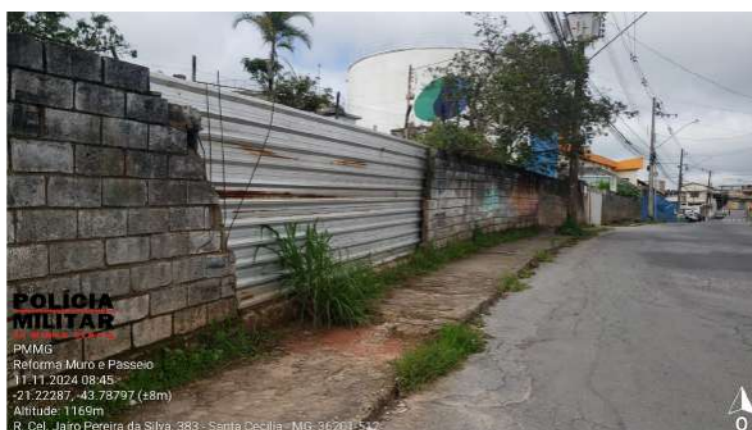
Figura 5 – Muro frontal: Parte desmoronada
