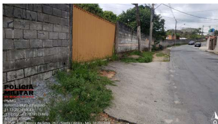
Figura 10 – Passeio frontal: deterioração, vegetação e desníveis
