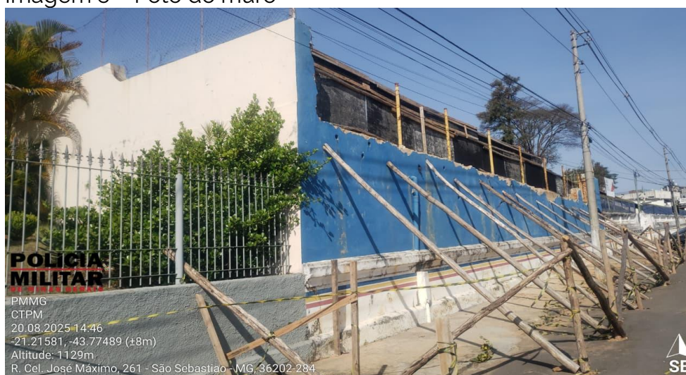
Imagem 5 – Foto do muro
