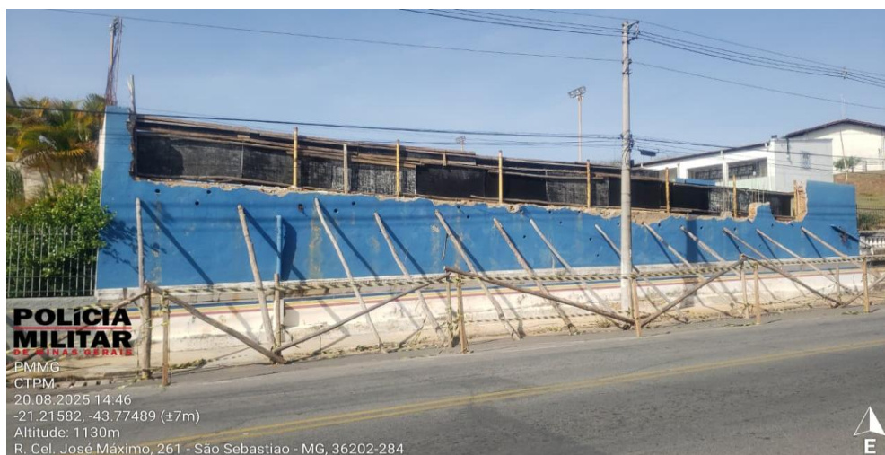
Imagem 6 – Foto do muro
