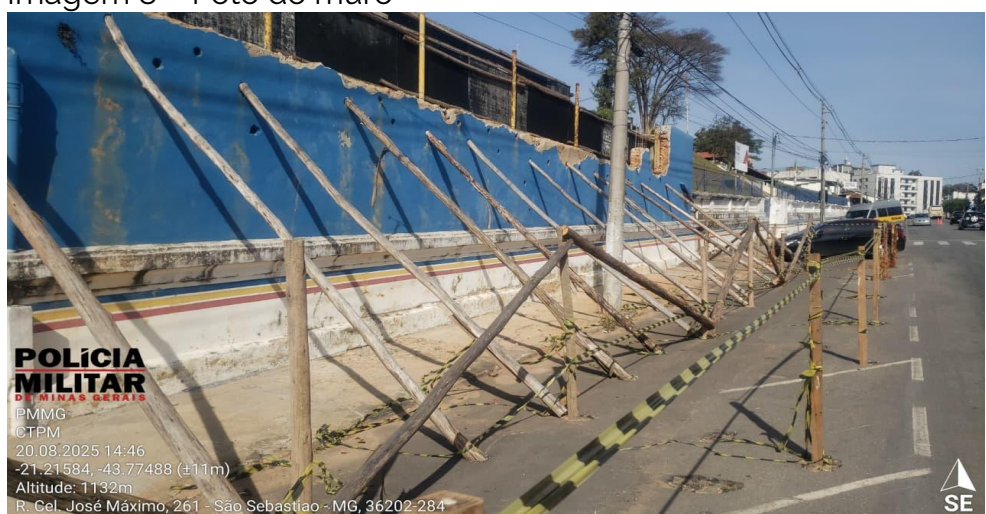
Imagem 8 – Foto do muro
