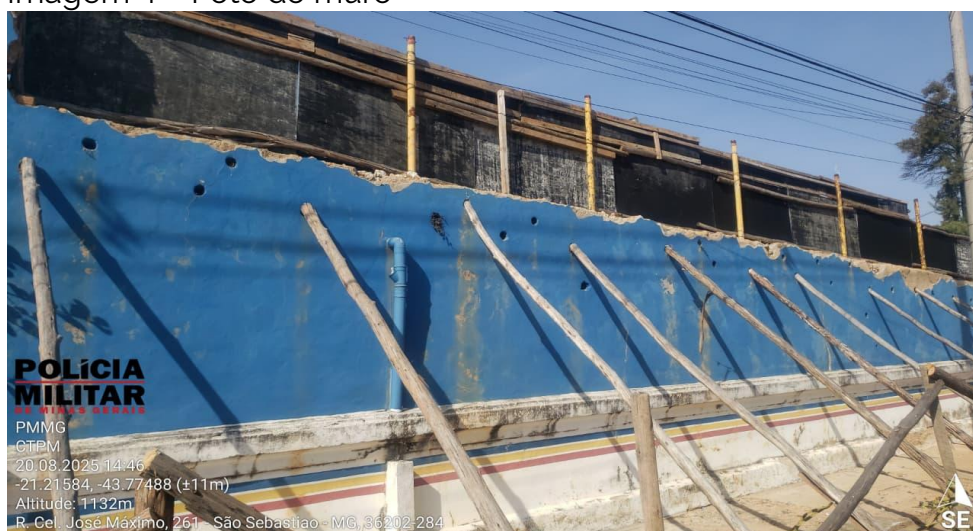
Imagem 4 – Foto do muro
