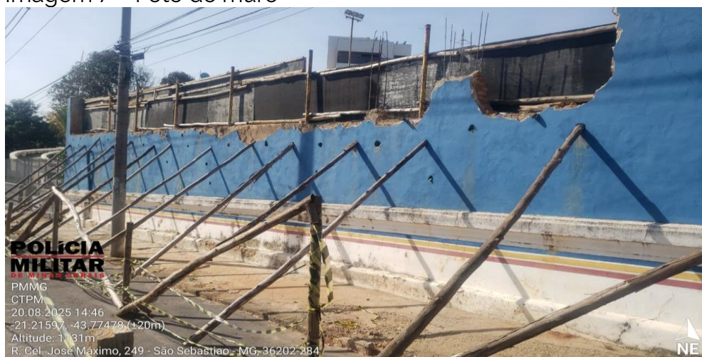
Imagem 7 – Foto do muro
