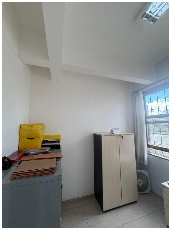
Foto 1 - Local da evaporadora
