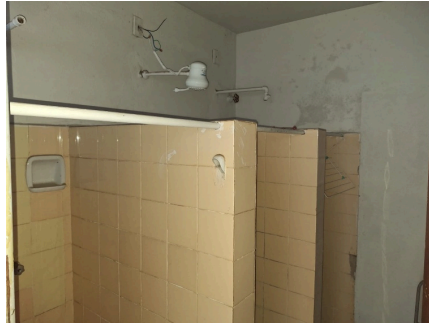
Imagem 1 – área de demolição e reconstrução
