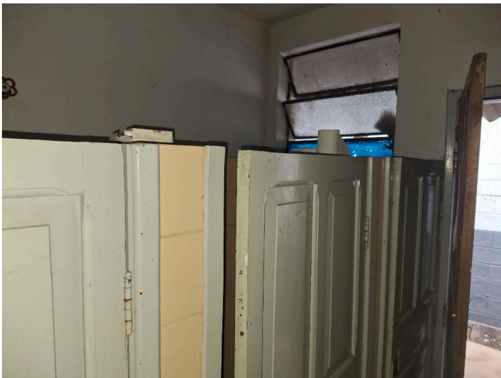
Imagem 2 – Foto das portas e janela a serem substituídas
