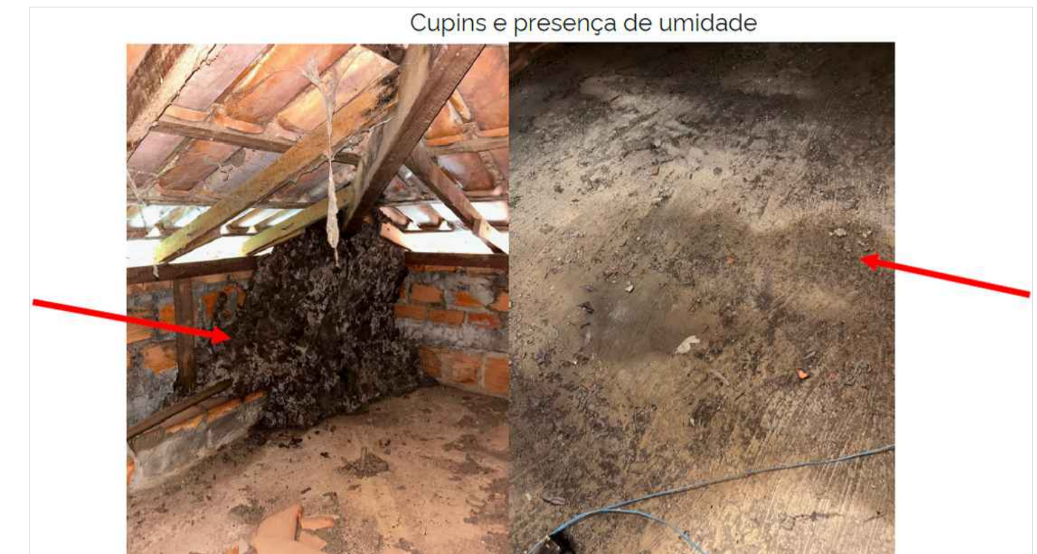
Fotos das estruturas de madeiras deterioradas.
