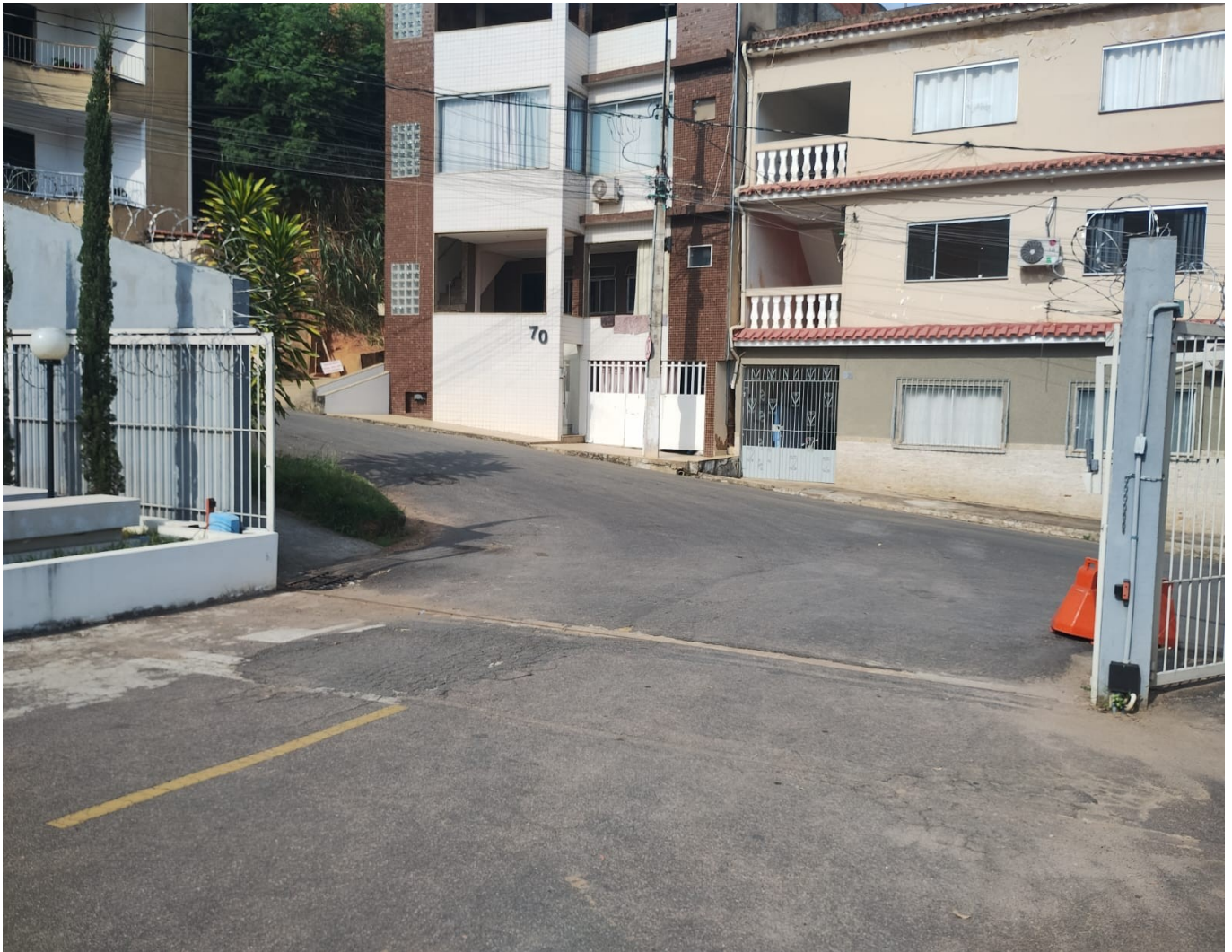
Fig. 02 – Vista interna do acesso principal do 47º BPM.
