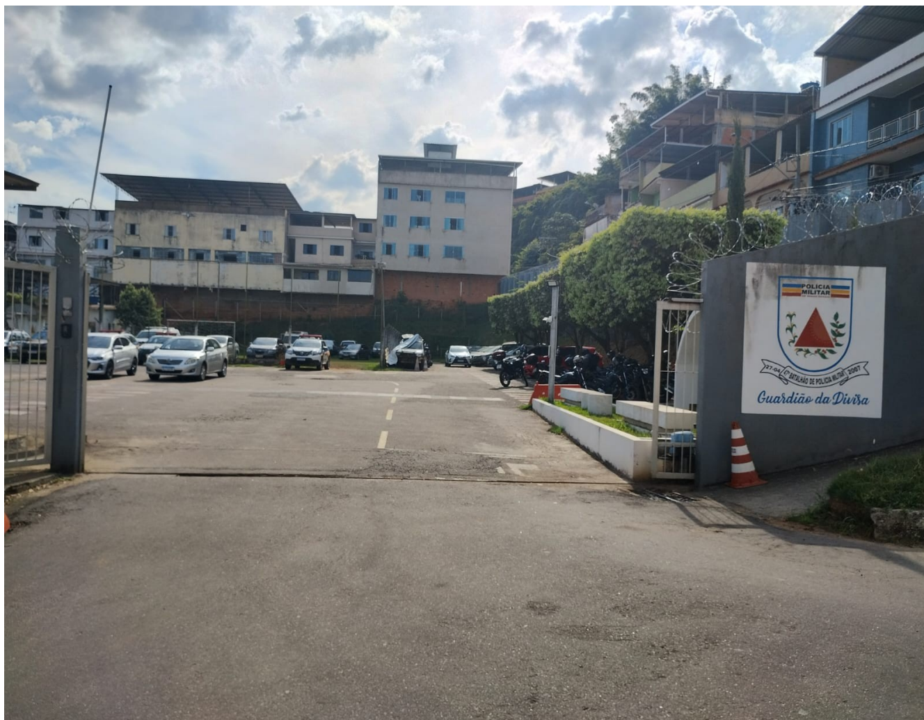
Fig. 01 – Vista frontal do acesso principal do 47º BPM.
