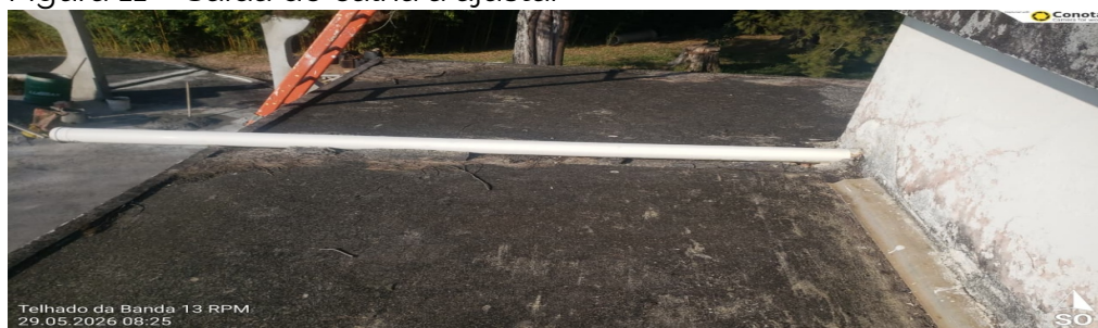
Figura 11 – Saída de calha a ajustar
