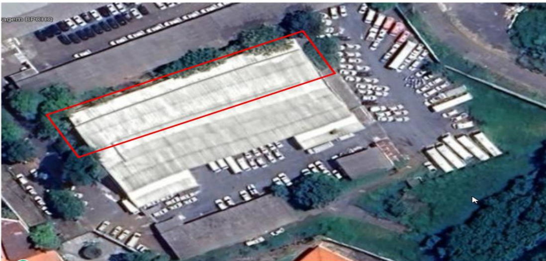
Figura 1 – Imagem de satélite da Oficina de Motomecanização do CMI (Google-2024) – Destaque do setor afetado pelas patologias.
