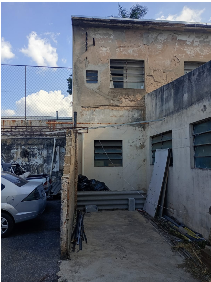
Figura 1 - Registro fotográfico da área indicada para a investigação geotécnica e futura implantação do reservatório.
