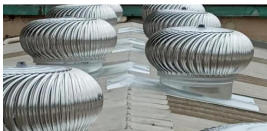
Fig. 07 – Melhoria no Sistema de Ventilação Existente
