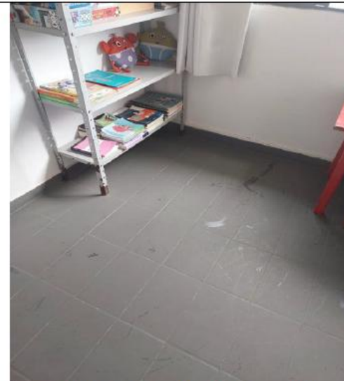
DESCRIÇÃO: Detalhe chão da Sala do Psicólogo
