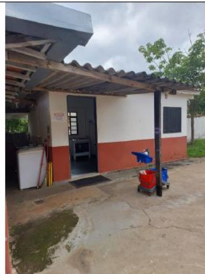
DESCRIÇÃO: Varanda Externa cozinha
