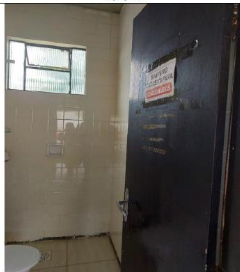
DESCRIÇÃO: Banheiro Primeiro Pav.
