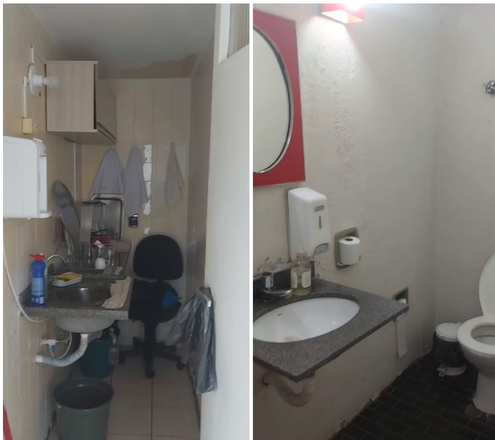
Da esquerda para a direita: Banheiro 01, Banheiro 02, Banheiro 03 (a ser convertido em minicopa) e Banheiro 04.
