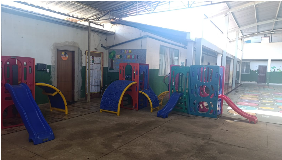
LADO DA AMPLIAÇÃO
