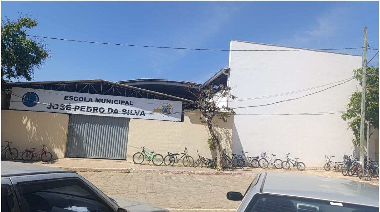
FRENTE PARA AVENIDA MINAS GERAIS
