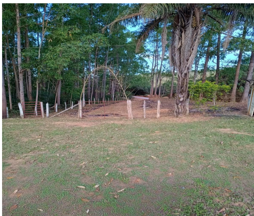
Figura 6: Estrada da Comunidade do Barreiro a ser pavimentada
