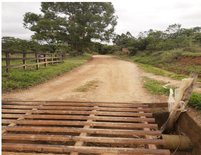
Figura 1: Início do trecho a ser pavimentado
