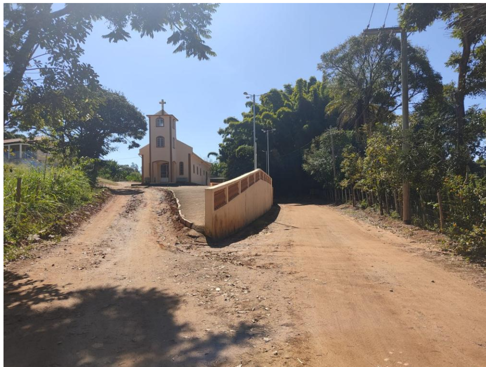
Figura 10: Estrada da Comunidade do Calafate a ser pavimentada
