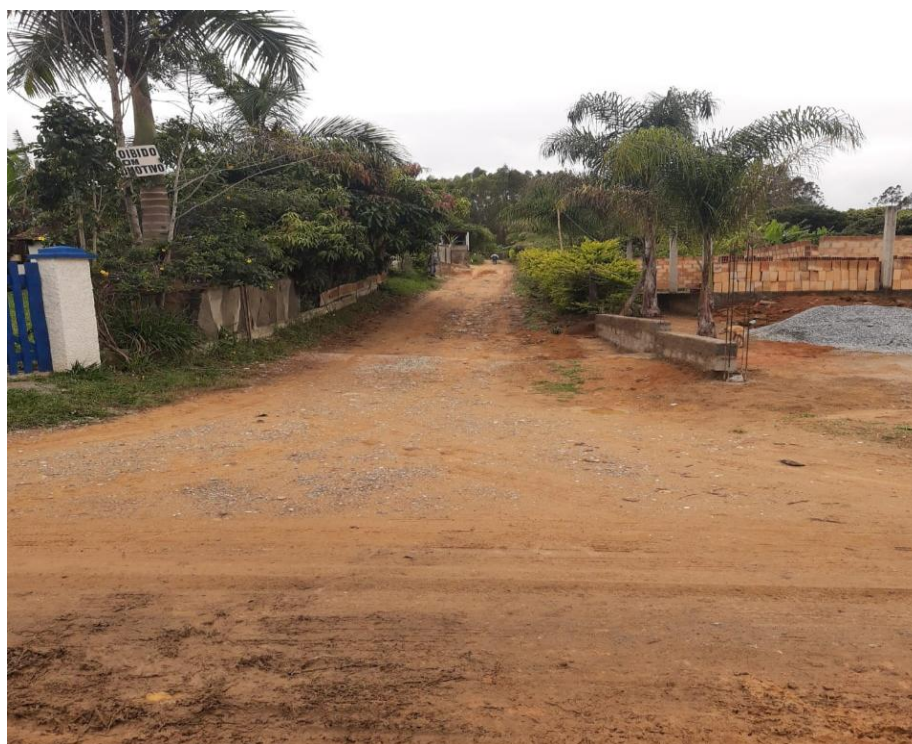
Figura 4: Estrada da Comunidade dos Faleiros a ser pavimentada
