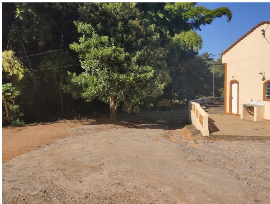
Figura 11: Estrada da Comunidade do Calafate a ser pavimentada
