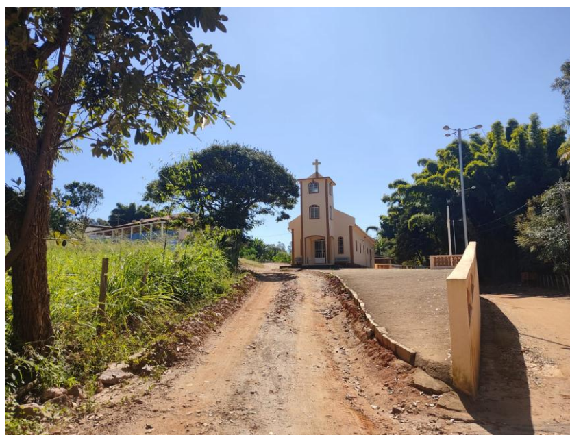
Figura 8: Estrada da Comunidade do Calafate a ser pavimentada
