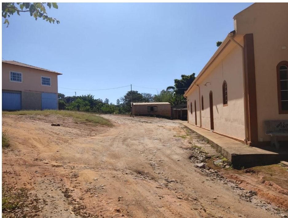
Figura 9: Estrada da Comunidade do Calafate a ser pavimentada
