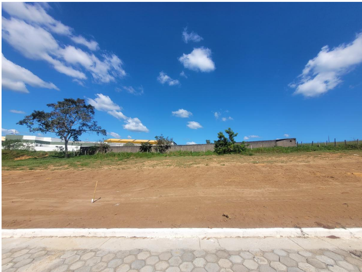
Figura 1: Local da Construção de Creche MODELO FNDE TIPO 1 no Bairro Alvorada – Rua 2
