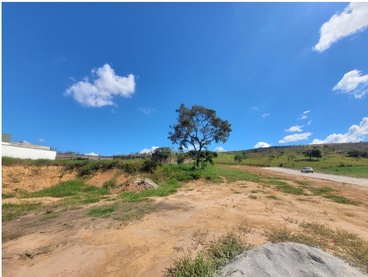
Figura 3: Local da Construção de Creche MODELO FNDE TIPO 1 no Bairro Alvorada – Rua 2
