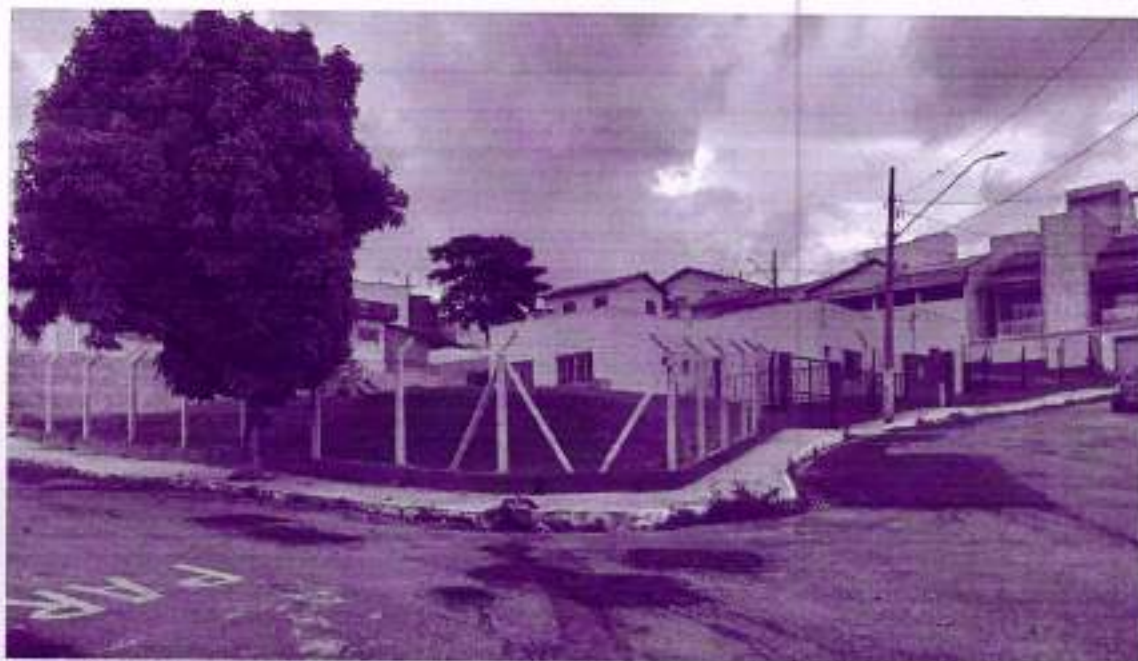
Figura 1: Local da execução, do muro de fechamento do Abrigo Raio de Luz End: Praça Luis Carlos Liu Mascarenhas Leite, nº 160 – B: Domingos Ribeiro
