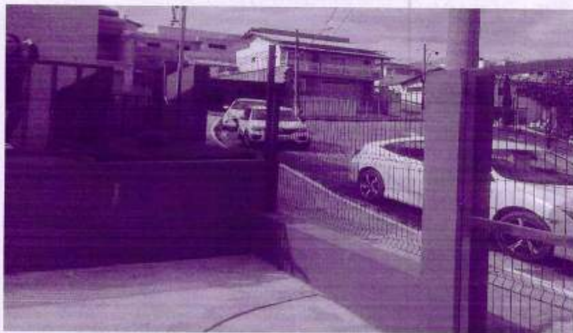
Figura 4: Local da execução, do muro de fechamento do Abrigo Raio de Luz End: Praça Luis Carlos Liu Mascarenhas Leite, nº 160 – B: Domingos Ribeiro
