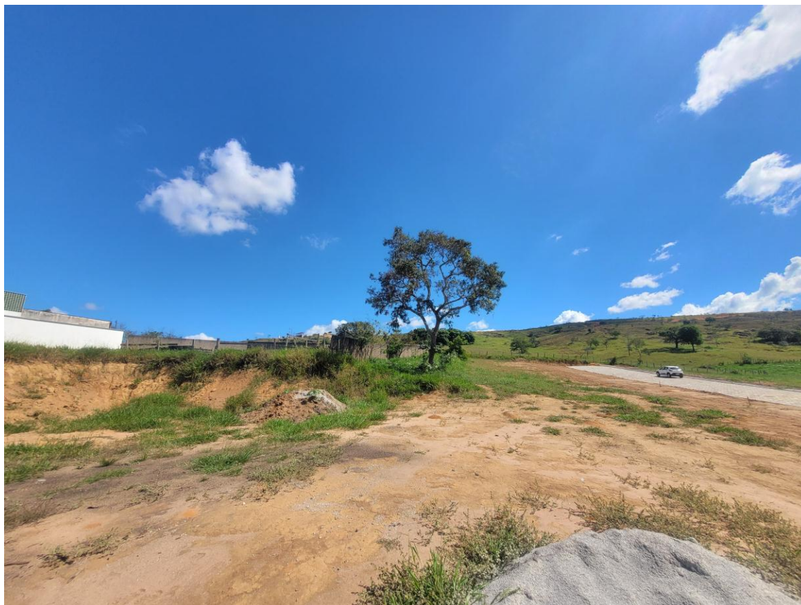
Figura 3: Local de execução construção do muro de arrimo, onde futuramente será construída Creche no Bairro Alvorada – Rua 2
