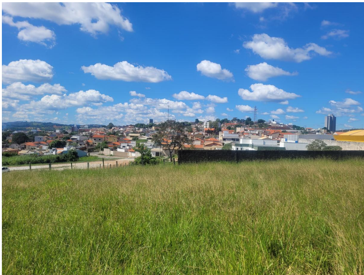
Figura 4: Local de execução construção do muro de arrimo, onde futuramente será construída Creche no Bairro Alvorada – Rua 2
