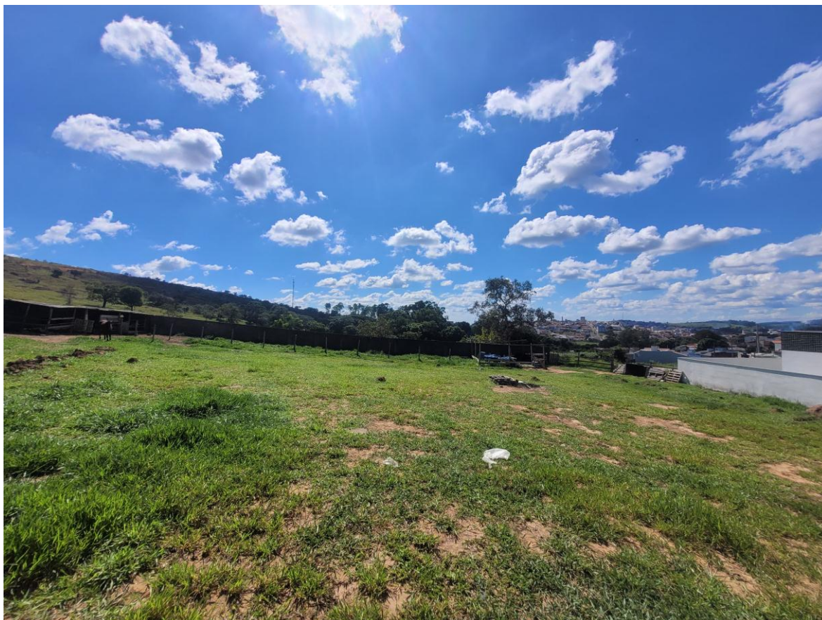
Figura 2: Local de execução construção do muro de arrimo, onde futuramente será construída Creche no Bairro Alvorada – Rua 2
