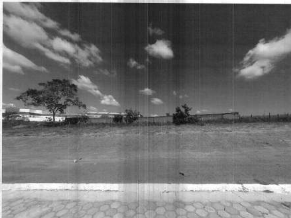
Figura 1: Local de execução construção do muro de arrimo, onde futuramente será construída Creche no Bairro Alvorada – Rua 2
