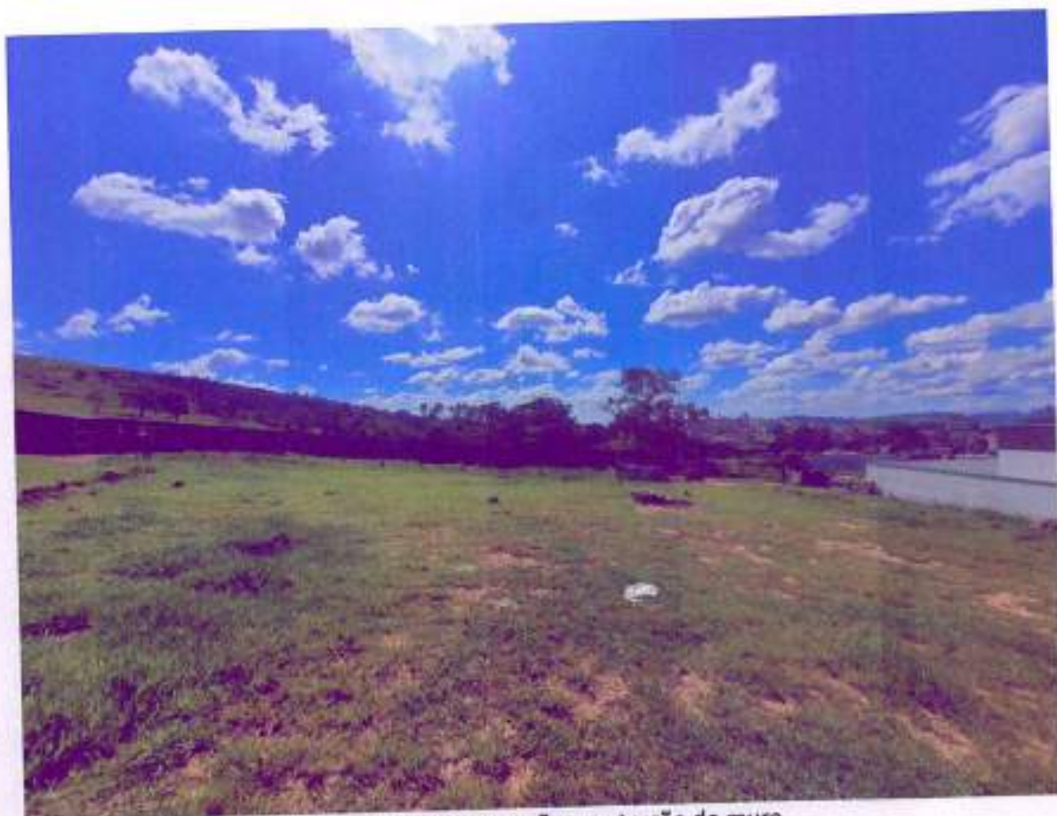
Figura 2: Local de execução construção do muro de arrimo, onde futuramente será construída Creche no Bairro Alvorada – Rua 2
