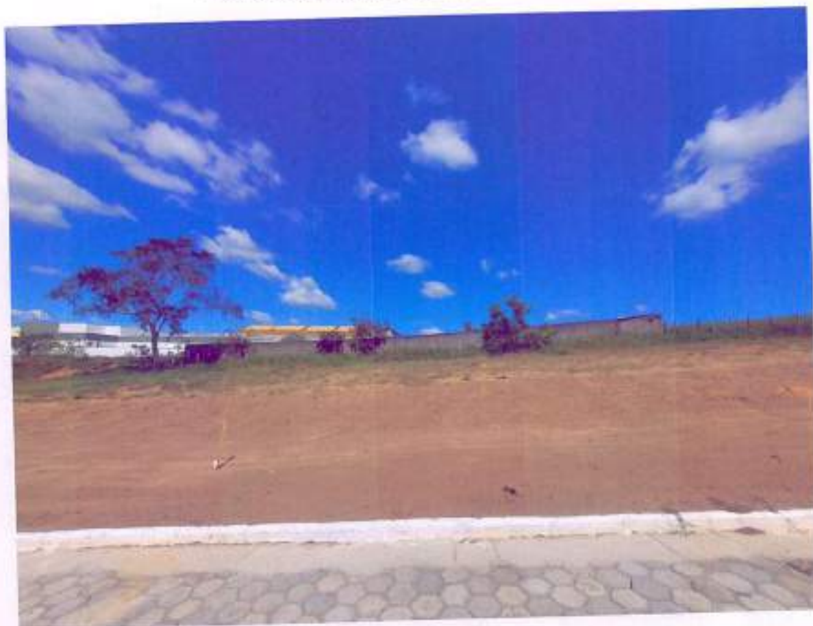
Figura 1: Local de execução construção do muro de arrimo, onde futuramente será construída Creche no Bairro Alvorada – Rua 2
