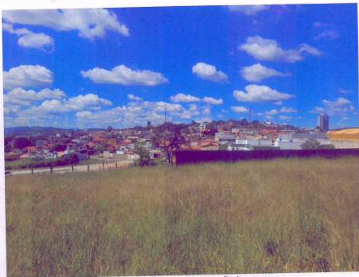
Figura 4: Local de execução construção do muro de arrimo, onde futuramente será construída Creche no Bairro Alvorada – Rua 2
