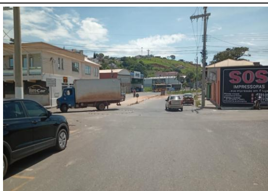
Imagem 2: Local onde terá início a adutora, interligando na adutora existente.
