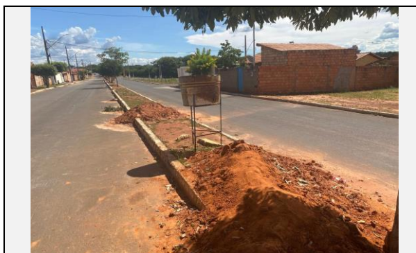
Descrição da fotografia CANTEIRO CENTRAL AV. MÉDICE Foto 6 Data da fotografia 01/04/2025
