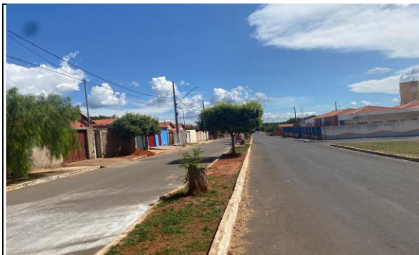
Descrição da fotografia CANTEIRO CENTRAL AV. MÉDICE Foto 1 Data da fotografia 01/04/2025
