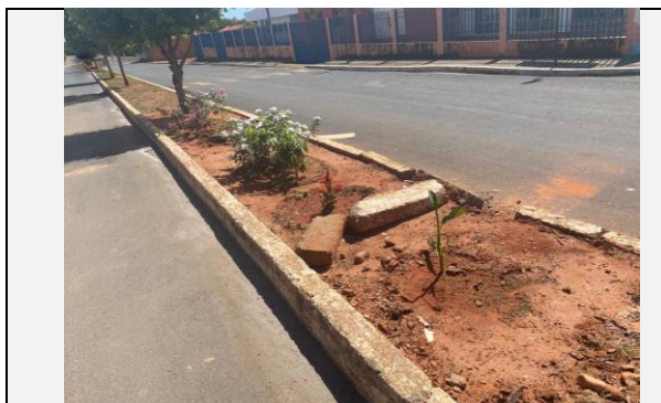
Descrição da fotografia CANTEIRO CENTRAL AV. MÉDICE Foto 4 Data da fotografia 01/04/2025
