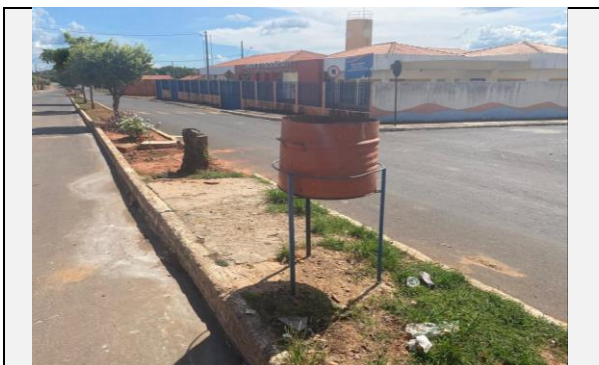
Descrição da fotografia CANTEIRO CENTRAL AV. MÉDICE Foto 3 Data da fotografia 01/04/2025
