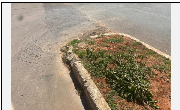
Descrição da fotografia CANTEIRO CENTRAL AV. MÉDICE Foto 5 Data da fotografia 01/04/2025
