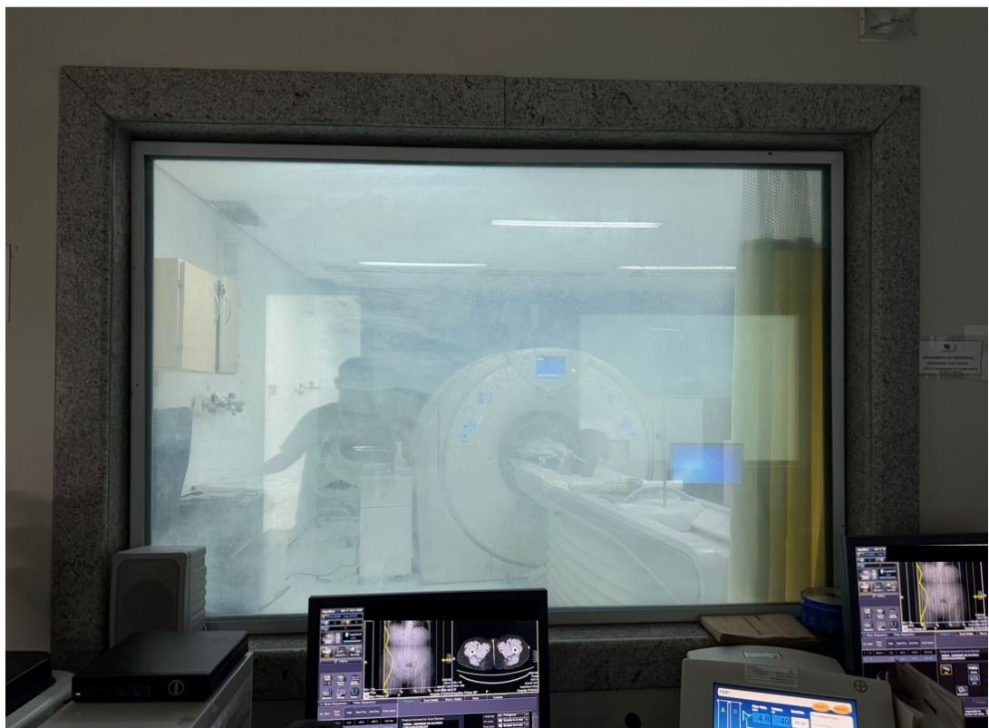
TOMOGRAFIA 1 - VISTA DA SALA DE COMANDO
