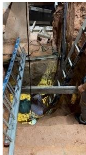
Figura 10: Vista do poço de visita executado paralelo ao P43. Fonte: PRA/UFMG. Data: novembro de 2022.
