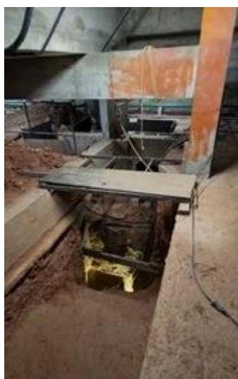
Figura 10: Vista do poço de visita executado paralelo ao P43. Fonte: PRA/UFMG. Data: novembro de 2022.
