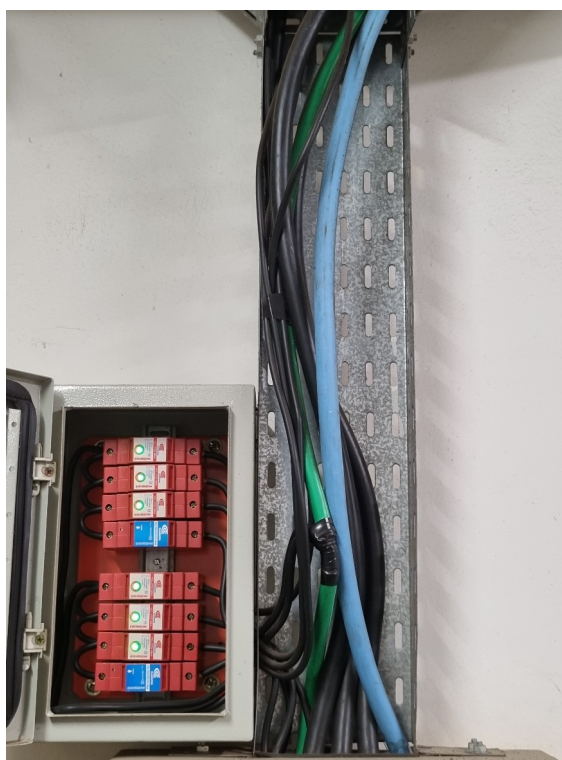
Figura 3: Quadro dos transmissores e DPS
