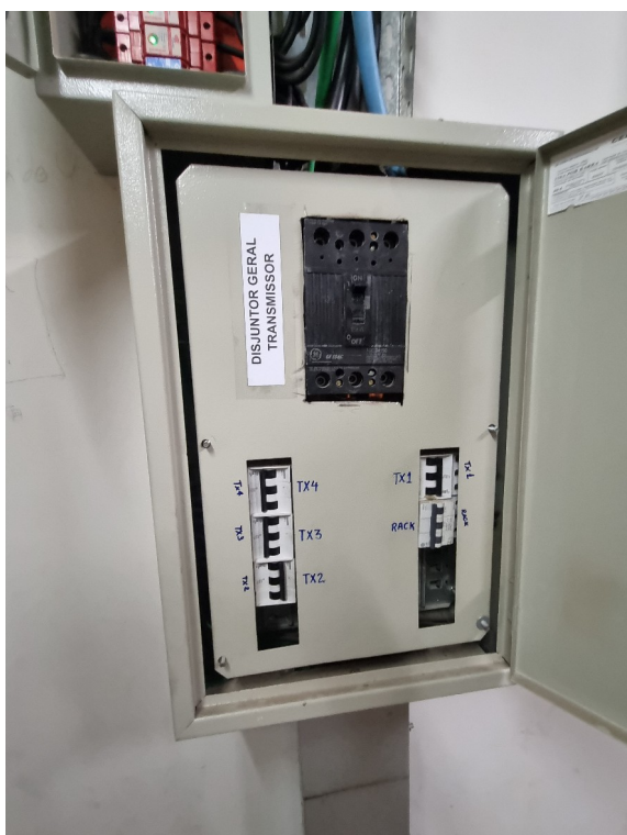
Figura 3: Quadro dos transmissores e DPS
