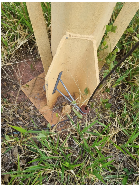
Figura 2: Aterramento
