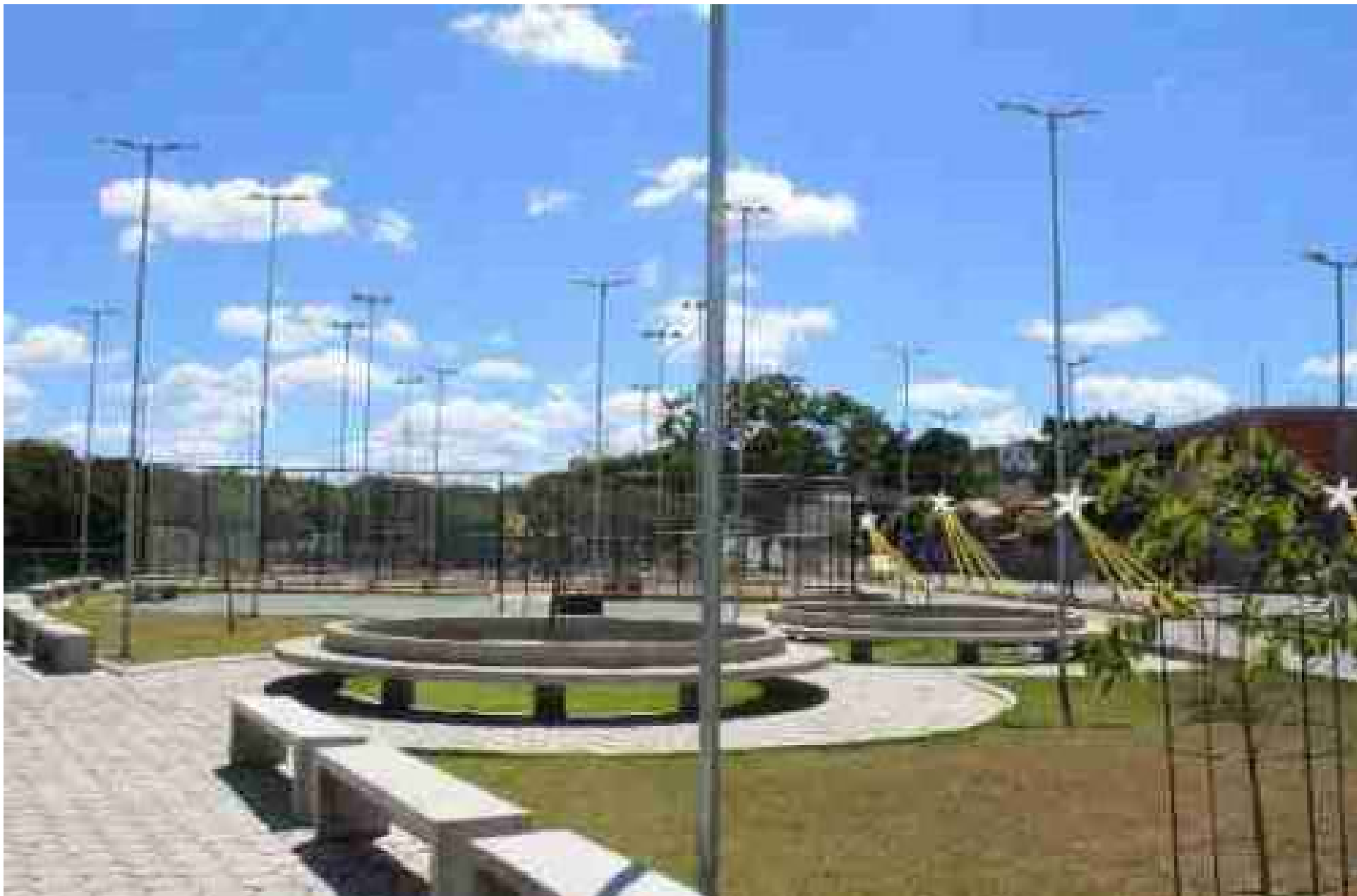
NOS POSTES DE ILUMINAÇÃO NO MEIO DAS RUAS, ESTRELA BRANCO FRIO NA PONTA COM RAIOS DE MANGUEIRA DE LED BRANCO QUENTE PARA O CHÃO.
