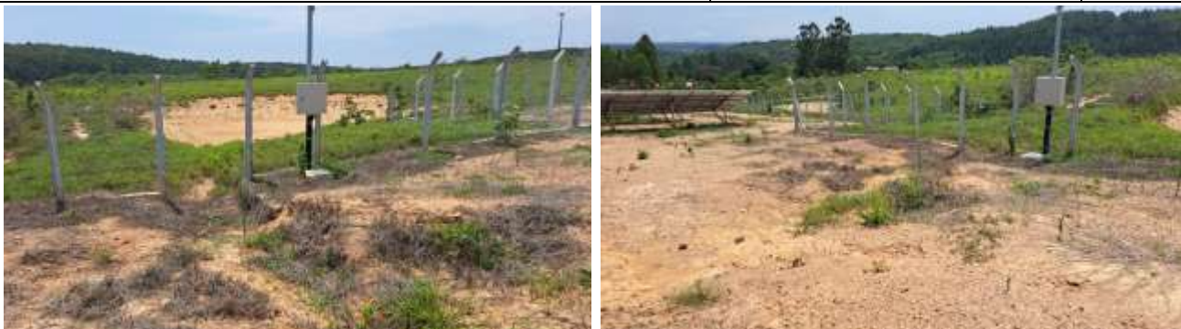
Figura 6.10 – Processo erosivo que direciona a água para a bacia de retenção na área lateral da usina
