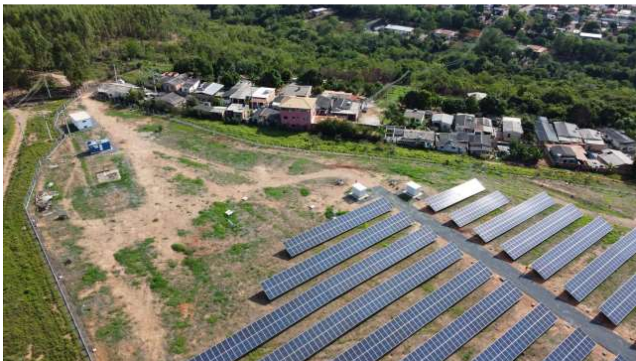
Figura 6.13 - Vista superior da área da usina fotovoltaica com indicação do portão de acesso
