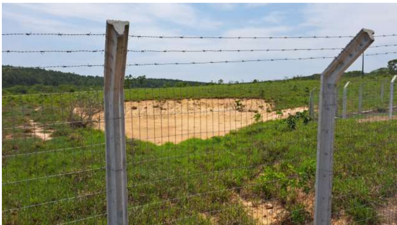
Figura 6.11 – Bacia de retenção de água da chuva na lateral da área da usina
