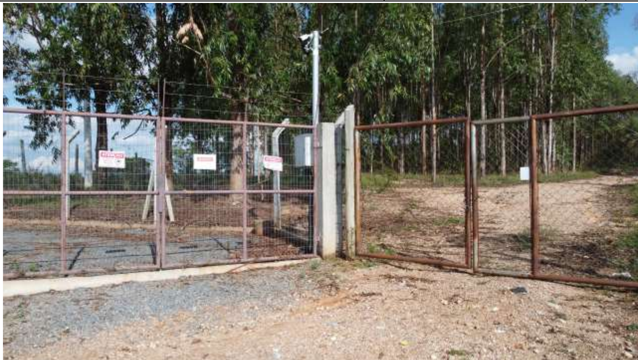
Figura 6.12 - Portão de acesso a usina fotovoltaica
