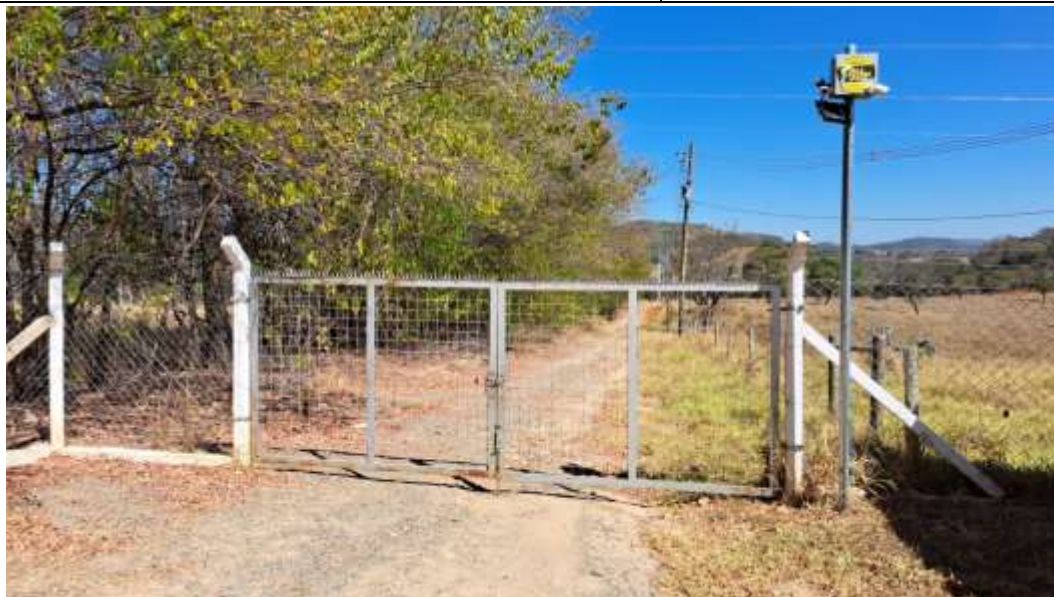
Figura 6.14 - Portão de acesso a usina fotovoltaica
