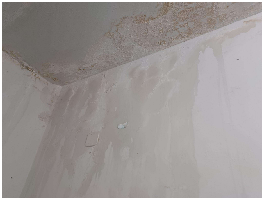
Imagem 09. – Infiltração
