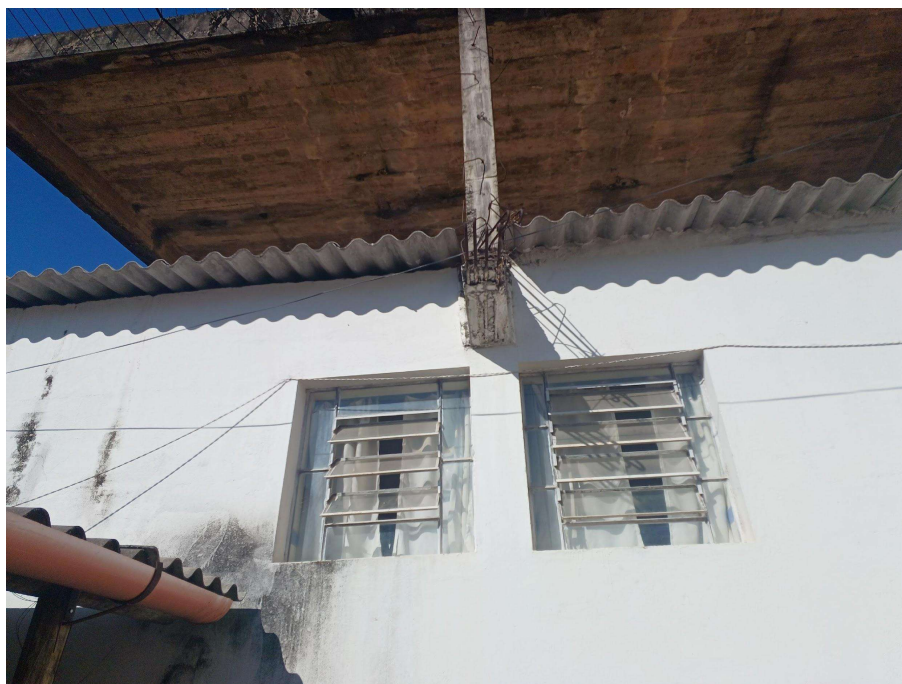
Imagem 03.- Elementos Estruturais Aparentes e Expostos a intempéries
