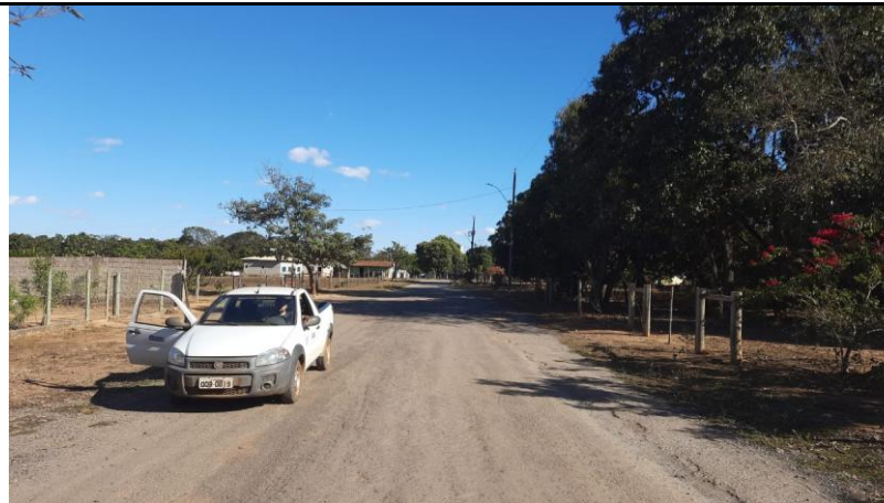
Descrição: Vista de um trecho da via.
